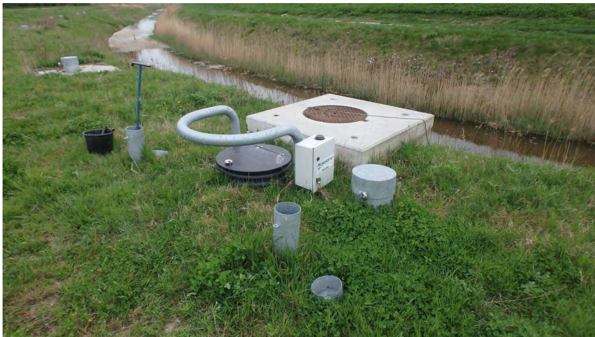
Figure 47. De twee afsluiters (stalen koker met deksel eraf) aan beide zijden van de regelput. Met de blauwe T-sleutel kunnen de spindel-afsluiters open en dicht worden gezet.
