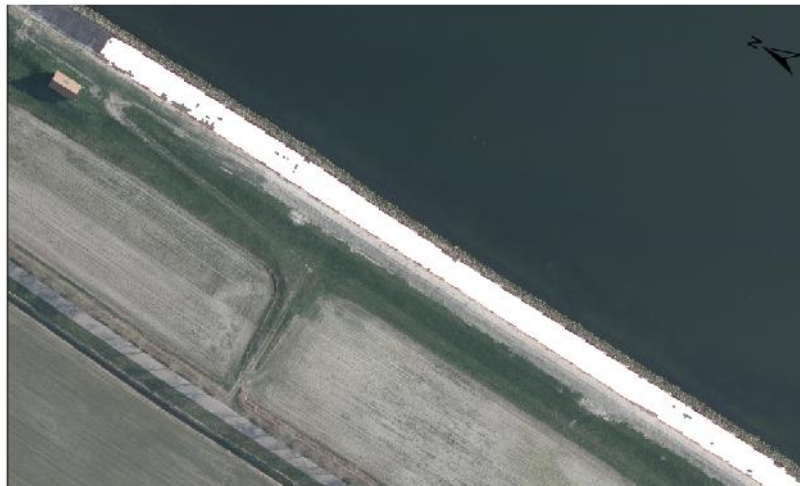
Uitvoering Inspectieprotocol Wieringermeerdijk
