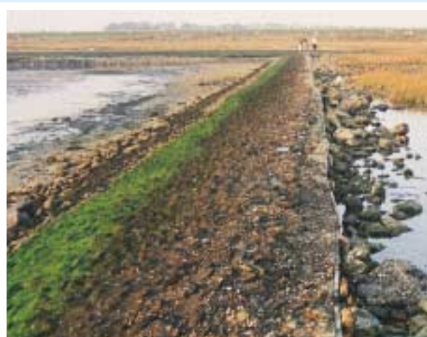
Foto 20 Ontgraving aan de achterzijde van de verdediging door overslag van golven, Gouweveerpolder (Oosterschelde).
