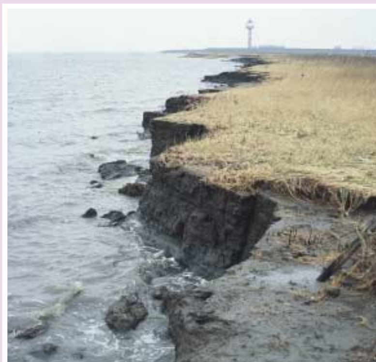
Foto 13 Het 2 meter hoge klif voor het schor van Waarde in 1997. Midden jaren tachtig was dit klif slechts 0,5 meter hoog.
