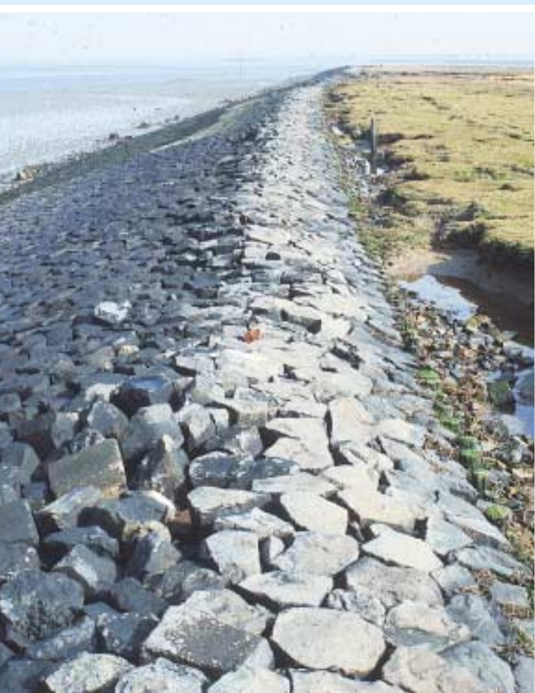
Foto 18 Het schor bij het Zijpe is in het begin van deze eeuw verdedigd met een stenen glooiing direct tegen het schor-klif. De verdediging is aangelegd door het Waterschap met als doel het schor als buffer te handhaven tegen de golfaanval op de aanliggende dijk. De verdediging heeft gewerkt, de schorerosie is gestopt. Zonder verdediging zou het schor helemaal verdwenen zijn, gezien het uitzonderlijk lage en smalle slik direct vóór de glooiing.
