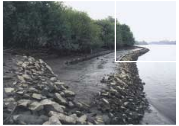
Foto 26 In de Zeeschelde bij Moerzeke-Kastel is terrasbouw toegepast als een milieuvriendelijke schorrandverdediging, bestaande uit parkoempalen en vlechtwerk van wilgentenen. Beoogd werd het steile slik op te delen in terrassen met flauwere hellingen. Hiermee wordt de golfenergie bij het schorklif gebroken maar tevens wordt hierdoor het oppervlak slik vergroot. Het blijkt een degelijk alternatief voor de ecologisch en vooral landschappelijk minder gunstige breuksteenbestortingen (Hoffmann et al, 1997).
