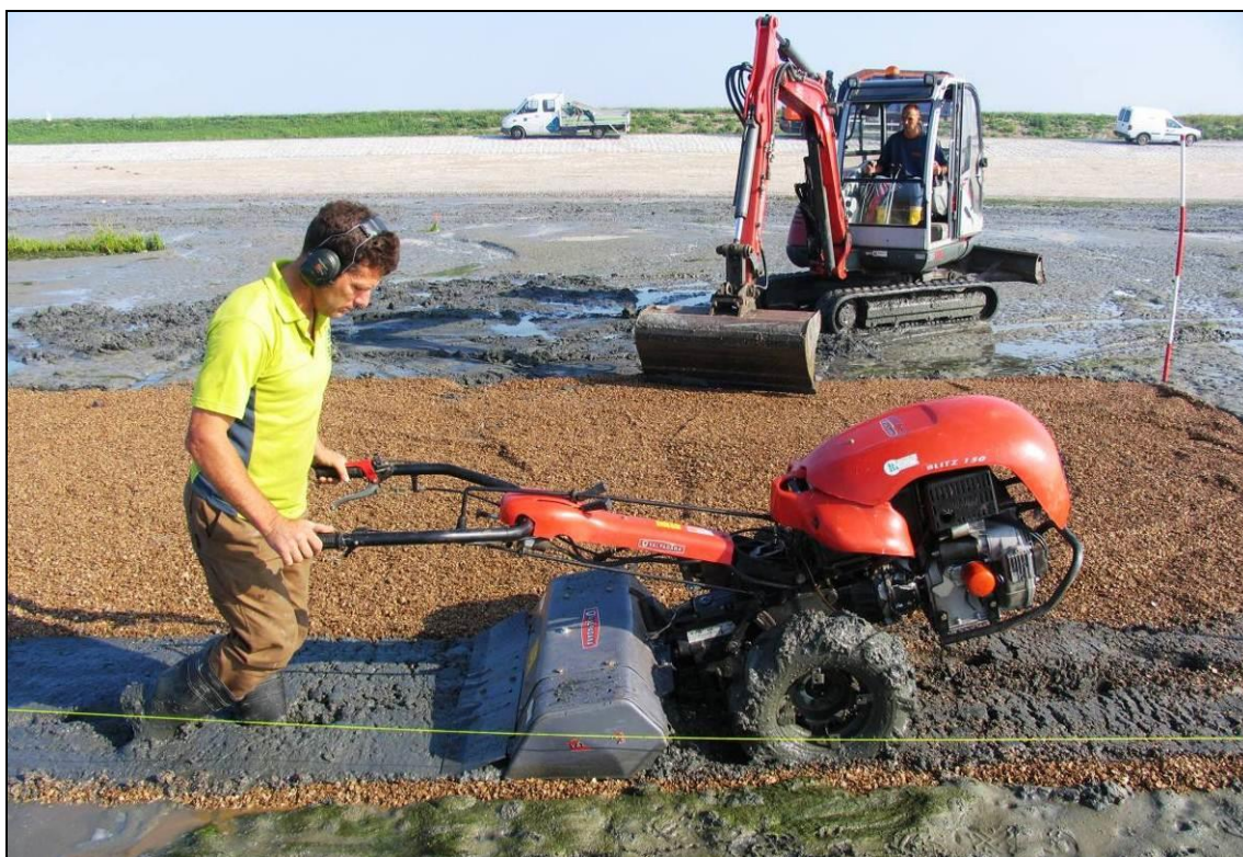
Foto 3 Aanbrengen schelpenlaag langs zeegrasveld op Dortsman Noord
