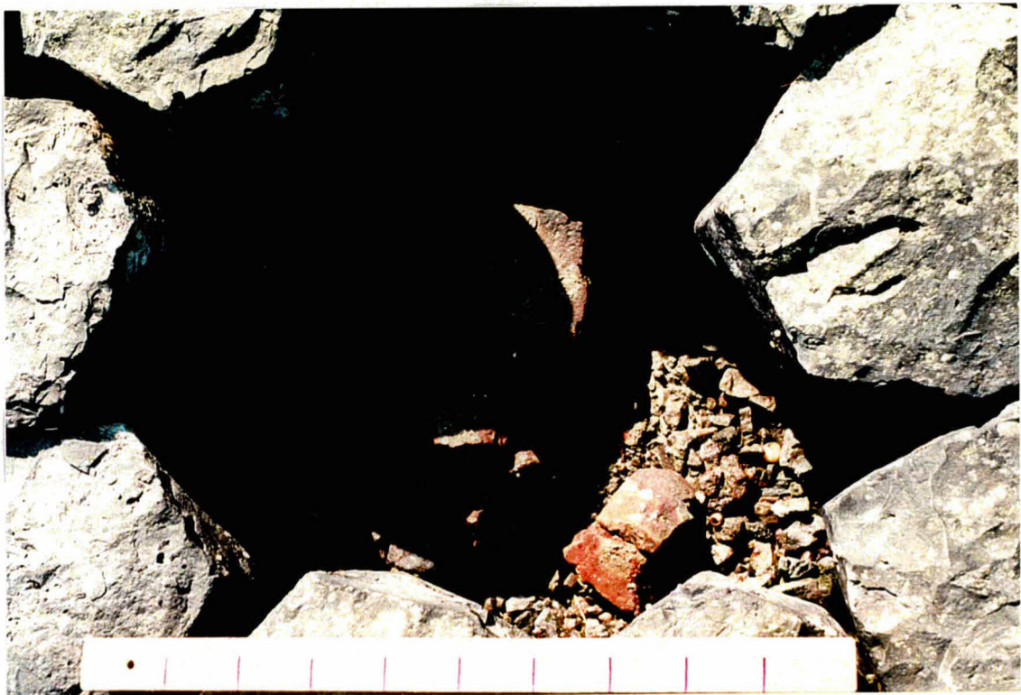
Foto 4 Voorbeeld van een open toplaag van basalt, met een vrij open filter. Let ook op de grote brokken baksteen. Dit kan van de vlijlaag afkomstig zijn, maar de brokken kunnen ook gebruikt zijn om de kleinere zuilen op te zetten.
