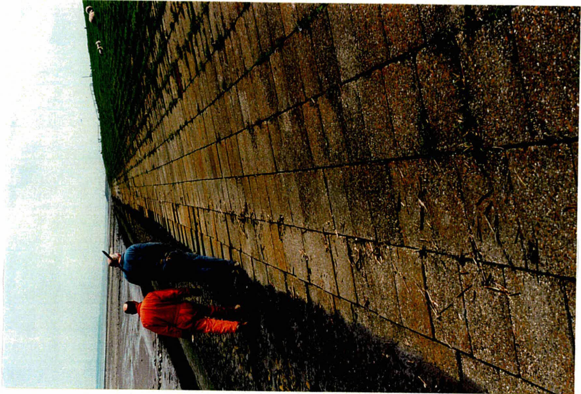
Foto 3 Het einde van de onderzochte strekking. De ondertafel bestaat uit basalt en doornikse steen, die deels is overgroeid met blaaswier
