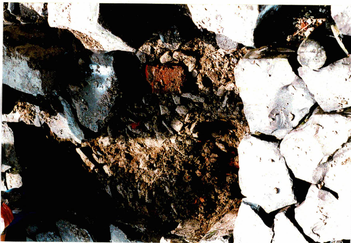
Foto 3 Voorbeeld van een volledig ingezande basaltzetting gevonden.
