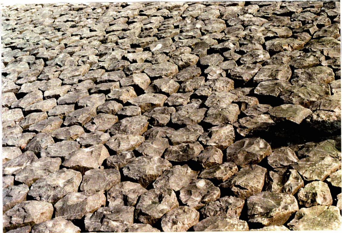
Foto 5 Dijkpaal 4: in het filter zit zand en tussen de spleten van de blokken zitten schelpen. Dit gat zet beneden de hoogwaterlijn.
