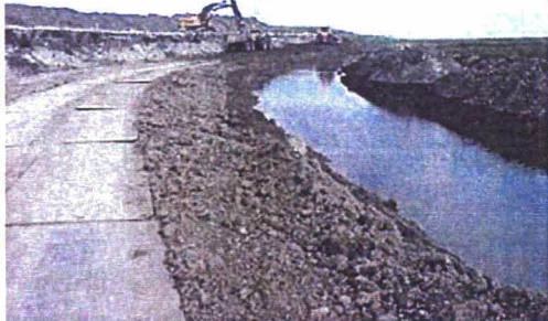
Foto 4.3. Aanvoerbaan met rijplaten.
