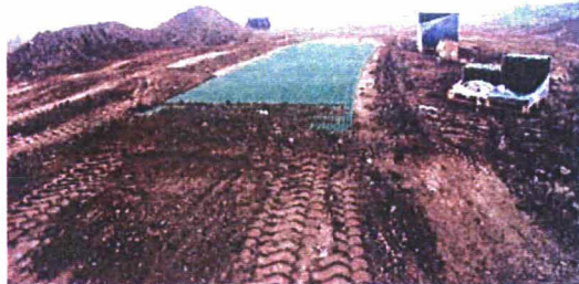
Foto 4.4. Aanbrengen kunststofgrasplaten.
