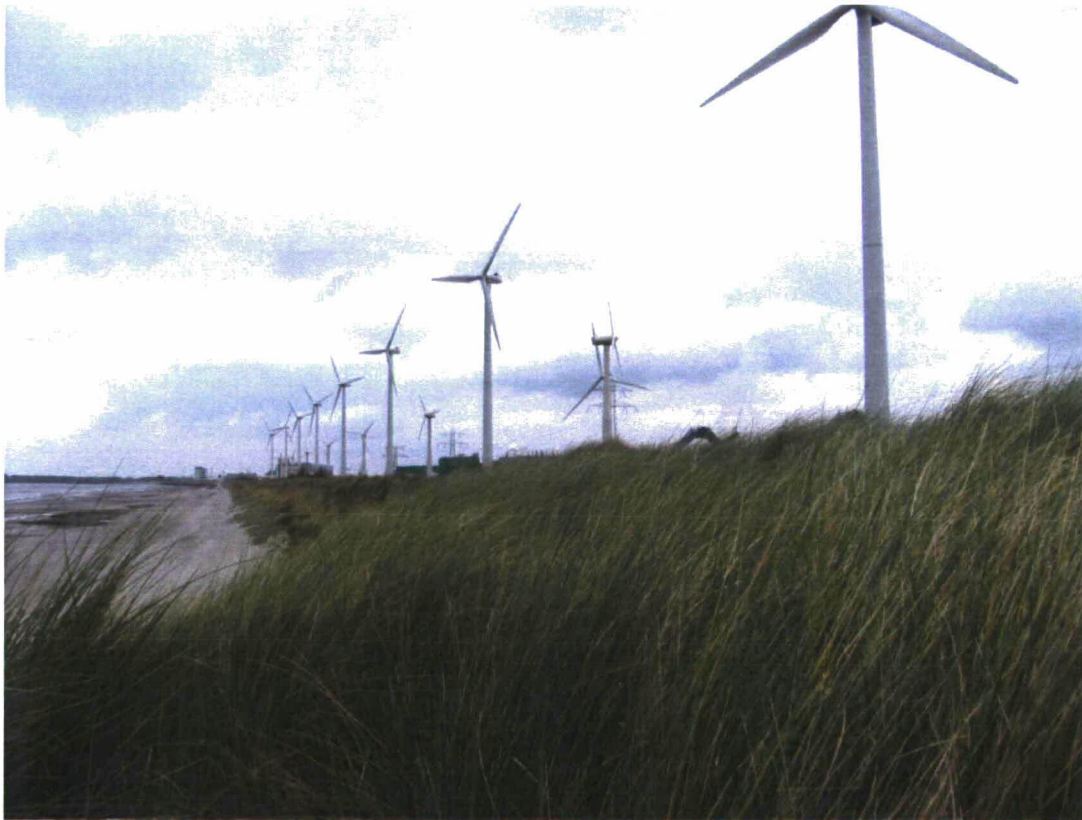
Duin overgaand in ondergestoven dijkgedeelte naar het westen
