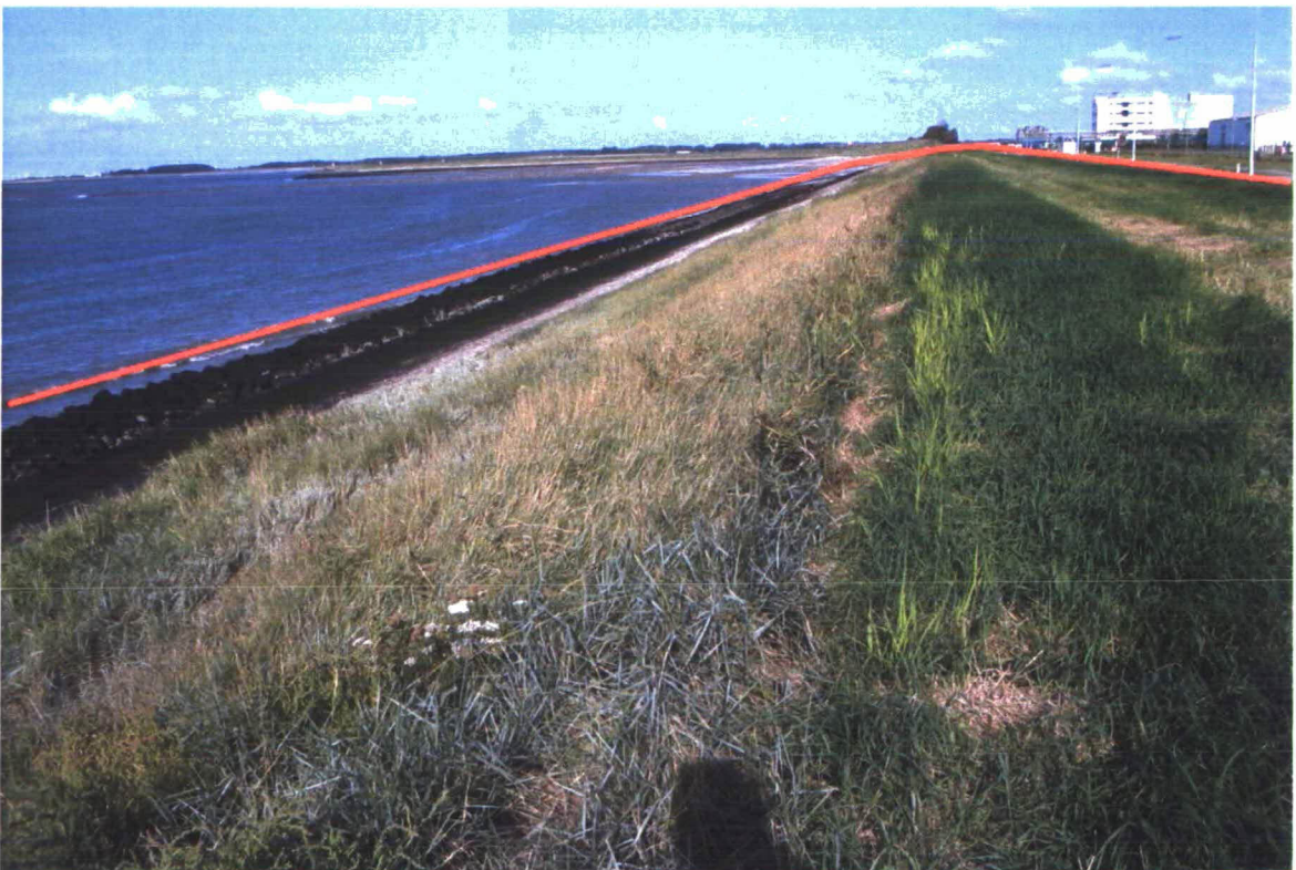
Westelijk deel zwakke zeewering aanbevolen reparatievak naar het westen gezien
