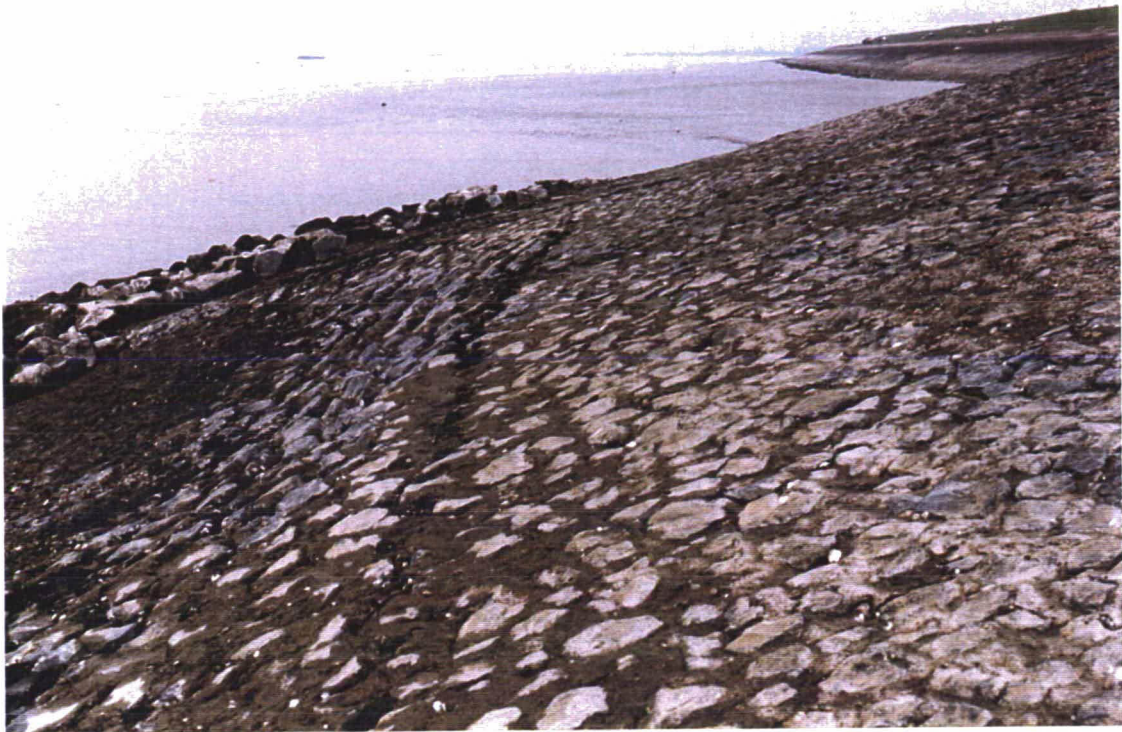
Foto 9 Bocht in het derde gedeelte: begin van het vak met asfalt gepenetreerde basalt (km 16,3, in westelijke richting genomen).
