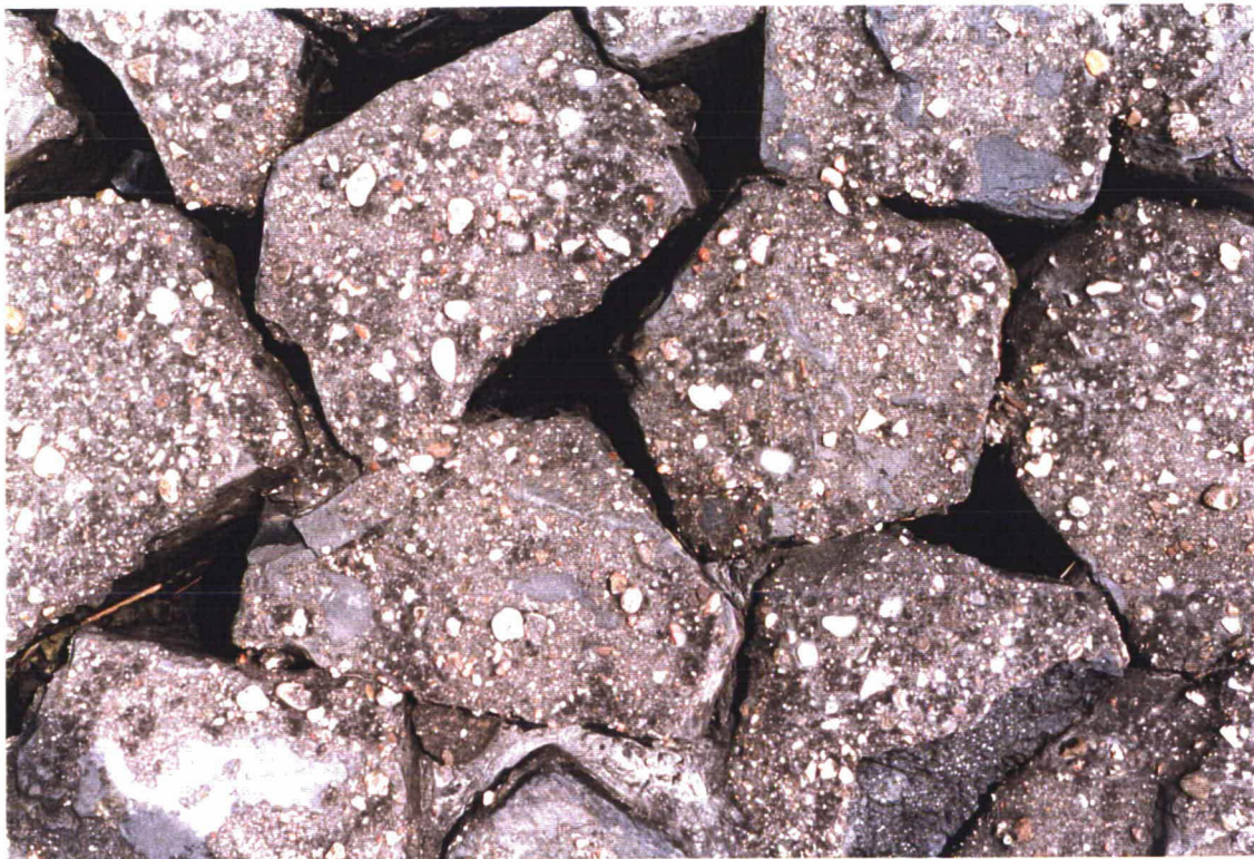
Foto 10 Plaatselijk is de penetratie verdwenen (km 16,3).
