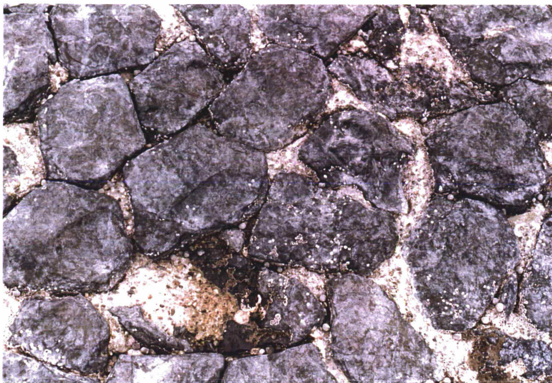
Foto 21 De betonpenetratie is op dit gedeelte beter blijven zitten (km 17,4).
