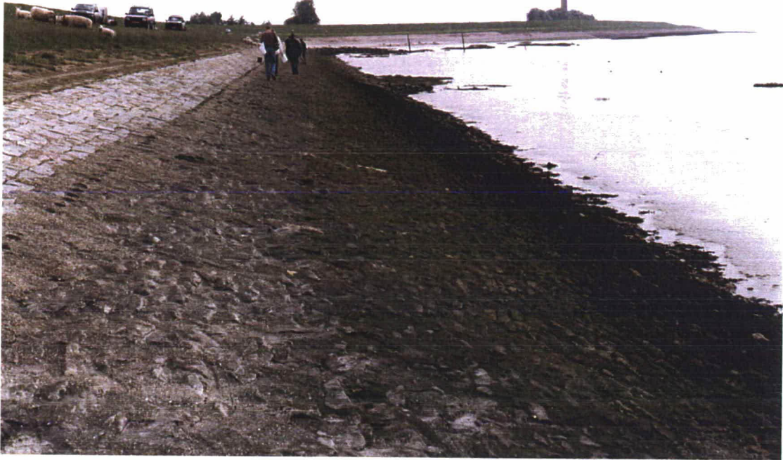
Foto 5: Overzicht van de locatie met beton gepenetreeerde Vilvoordse steen. Genomen bij km 15,8 in oostelijke richting.
