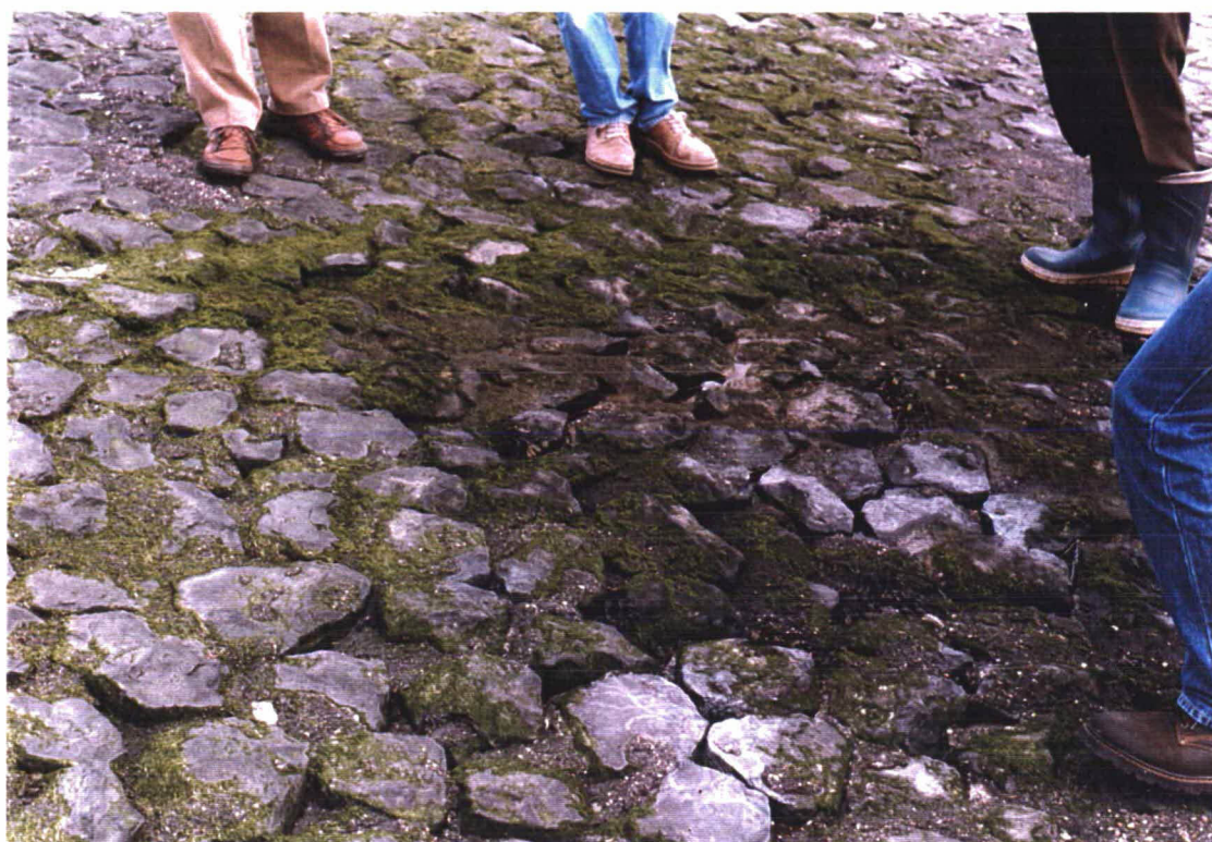
Foto 17: Een deuk in het talud (km 16,9).
