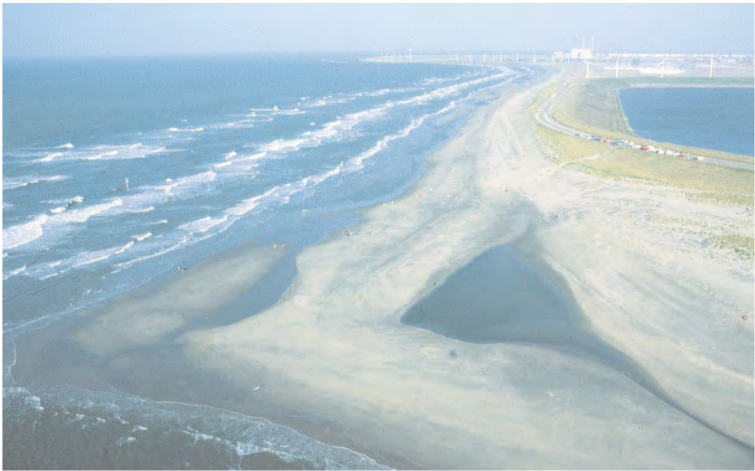
De Maasvlakte. Aanleg van een tweede Maasvlakte van 1000 ha vergt naar schatting 300 miljoen m 3 zand. Dat is 50 keer de hoeveelheid zand die nu jaarlijks voor het kustonderhoud wordt gesuppleerd.
