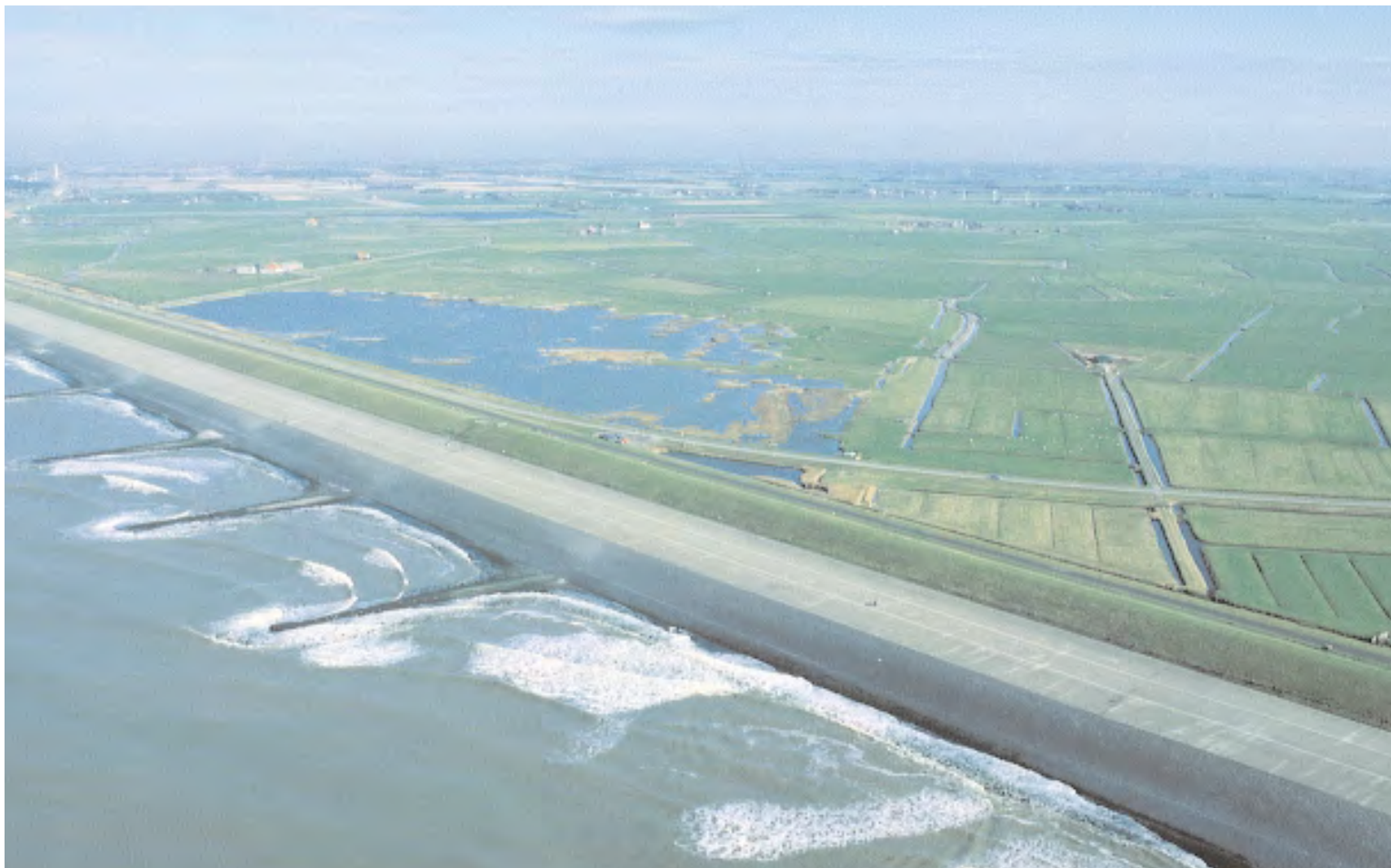
Hondschbosse Zeewering: 'harde' waterkeringen vormen sluitstuk van beleid.
