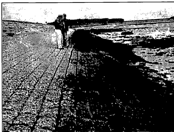
Foto's 1 en 2: vervorming in glooiing (dijkpaal 344+50m)
