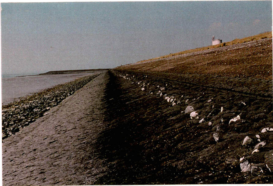
Foto 3 Verschil tussen de onderste en de bovenste strook gepenetreerde basalt, dp 4
