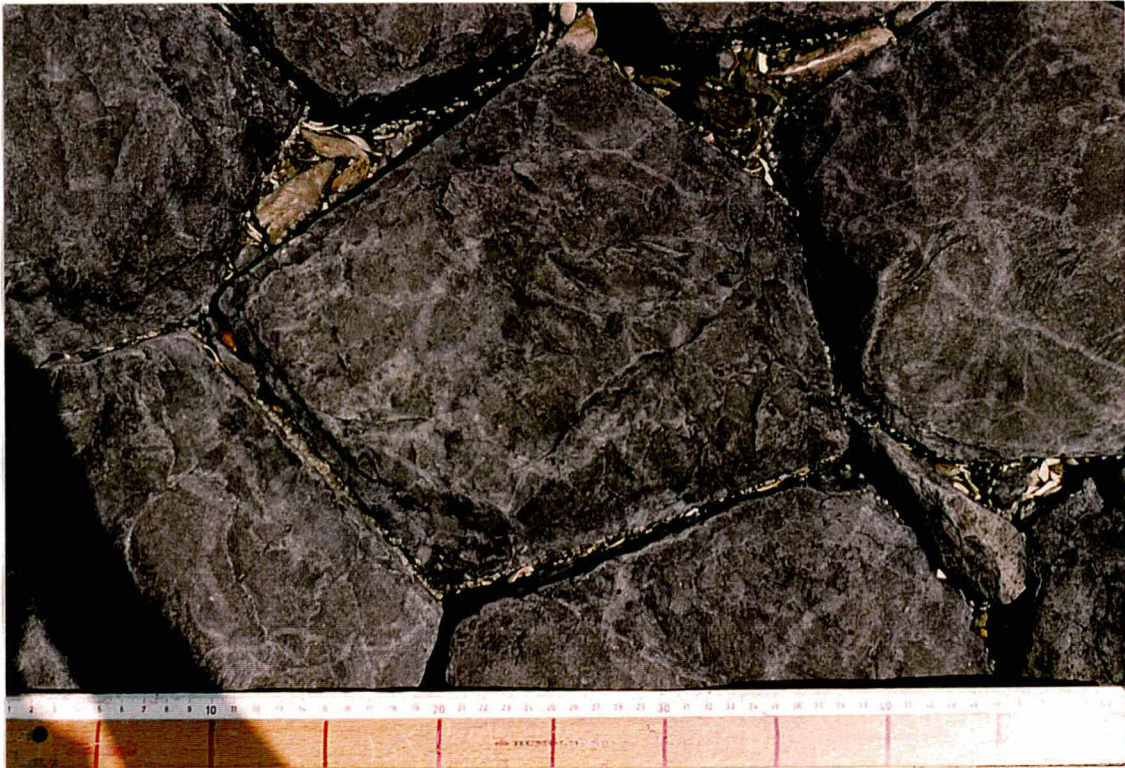
Foto 1 Dichtgeslibde basalt bij dp 2
