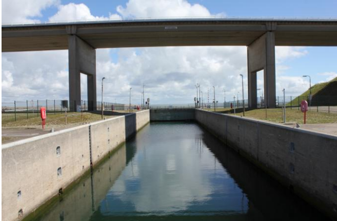
Afbeelding 3.4 Roompotsluis bekeken in de richting van de Oosterschelde
