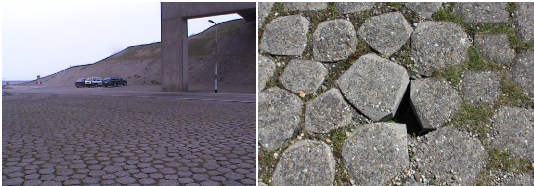
Afbeelding 3.5 Bekleding sluisplateau Roompotsluis
