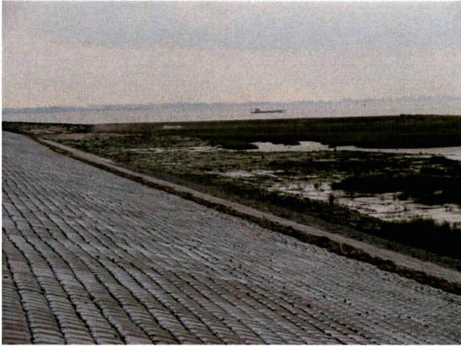
Dijkbekleding van betonzuilen, met behoud van de basaltzuilen in ondertafel
