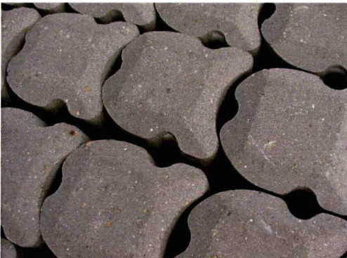
Nog aan te vullen betonzuilen
