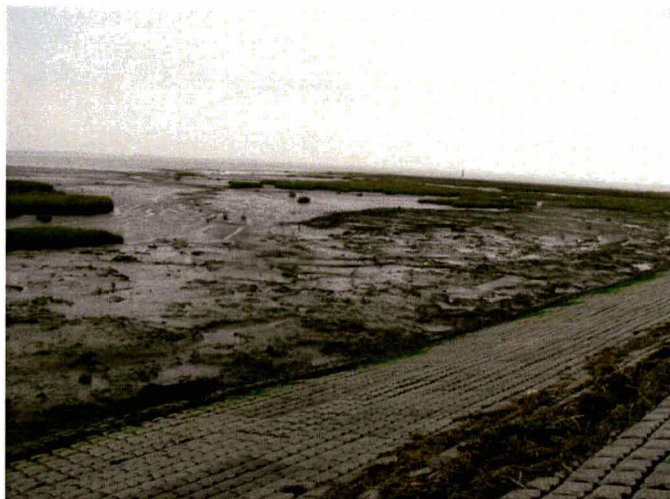
Locatie voormalige uitwateringssluis
