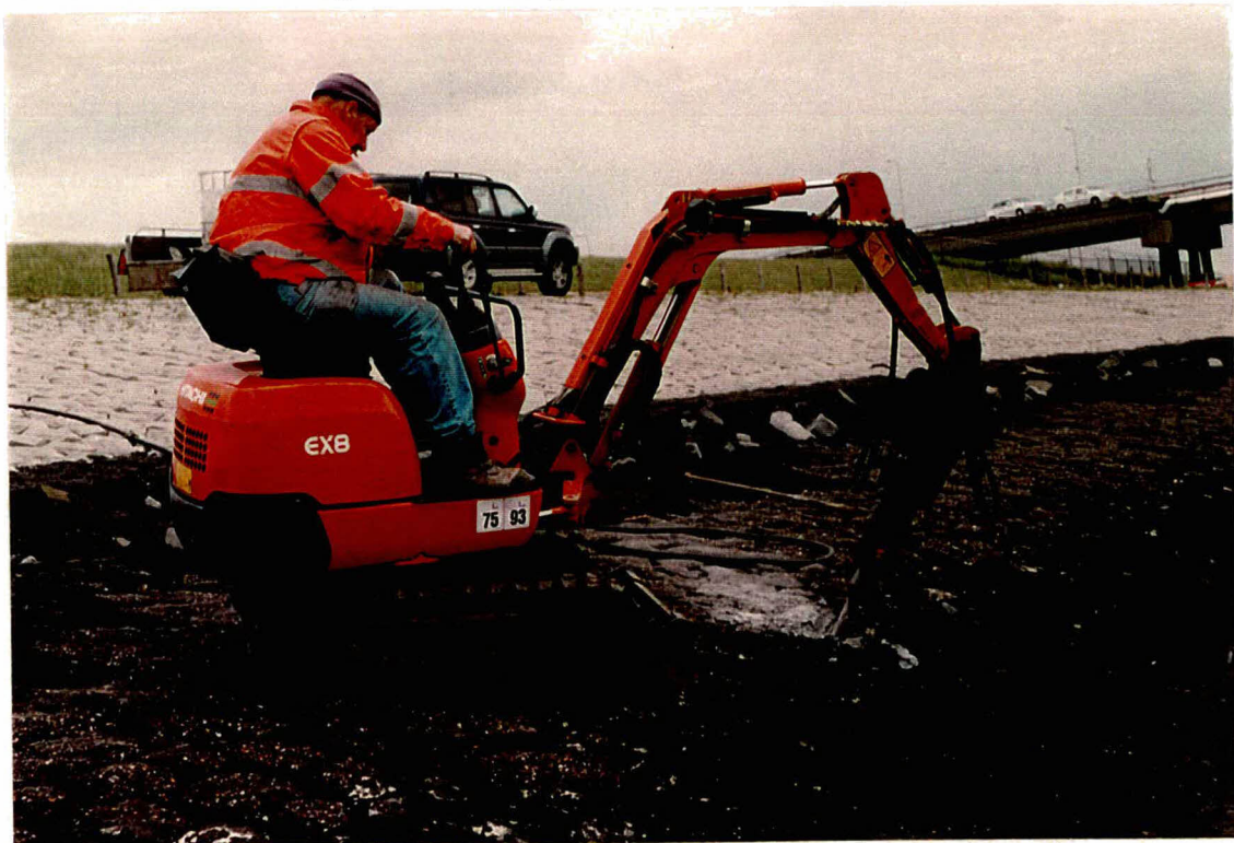
Foto 6 Breekwagentje. De penetratie is dusdanig dat de basalt kapotgebroken moet worden om een gat in de toplaag te kunnen maken.
