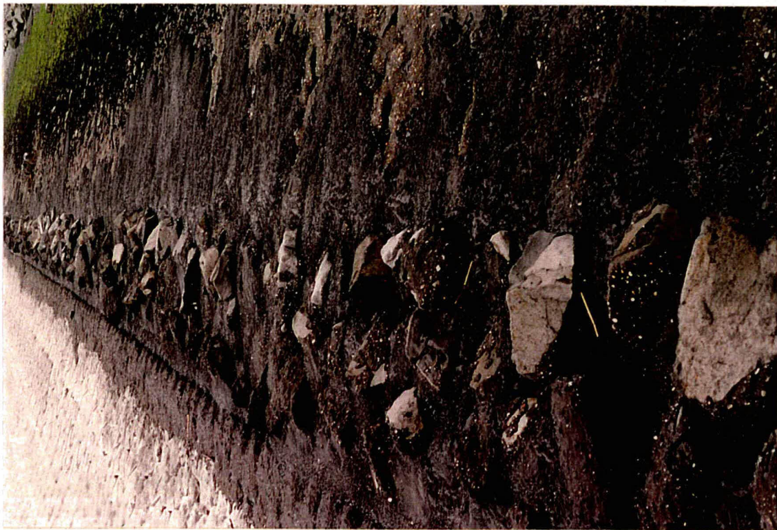
Foto 2 Beeld van de overgangsconstructie van gepenetreerde stortsteen
