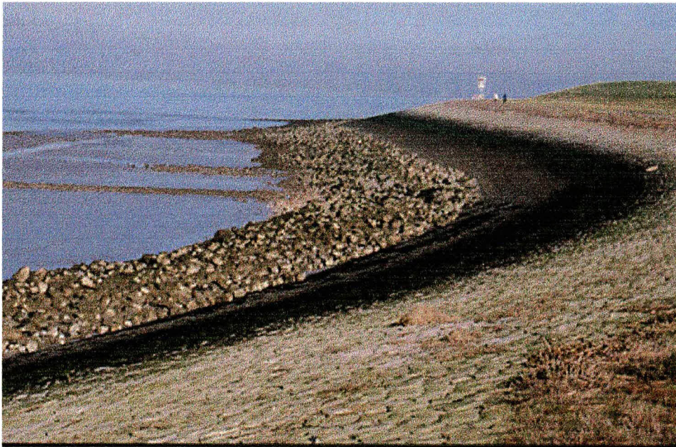
Zeedijk Kleine Huissenspolder, Zeeuwsch Vlaanderen, 15 februari 2001. Nieuw beklede zeedijk (uitgevoerd 1997): ondanks geringe hoeveelheid steenslag toch gebruikt als broedplaats door Strandplevier. Er is een brede overlaging aangebracht, die een barrière vormt voor jonge plevieren tussen dijk en slik (foto Peter L. Meininger)
