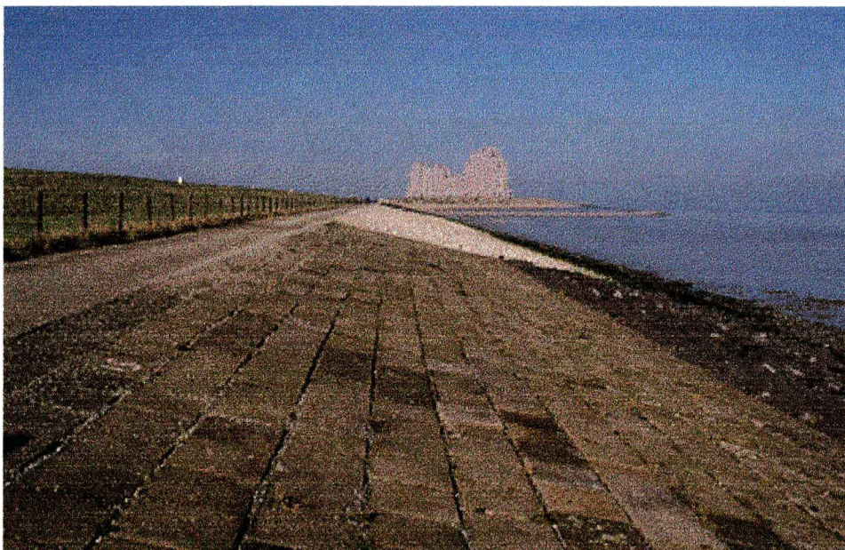
Zeedijk Elisabethpolder, Zeeuwsch Vlaanderen, 15 februari 2001. Nieuw beklede zeedijk (uitgevoerd 1999): kale, vlakke dijk (vooraan) of juist zeer reliëfrijk met beton overgoten stenen: ongeschikt voor broedende plevieren. Ook deze fietser liet zich niet tegenhouden. (foto Peter L. Meininger)
