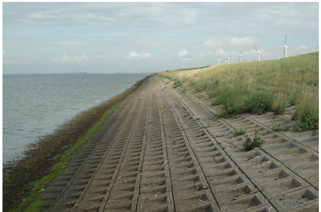
Foto 5.2: Zone van Haringmanblokken vanaf de koperslabblokken tot aan de zoutplanten.
