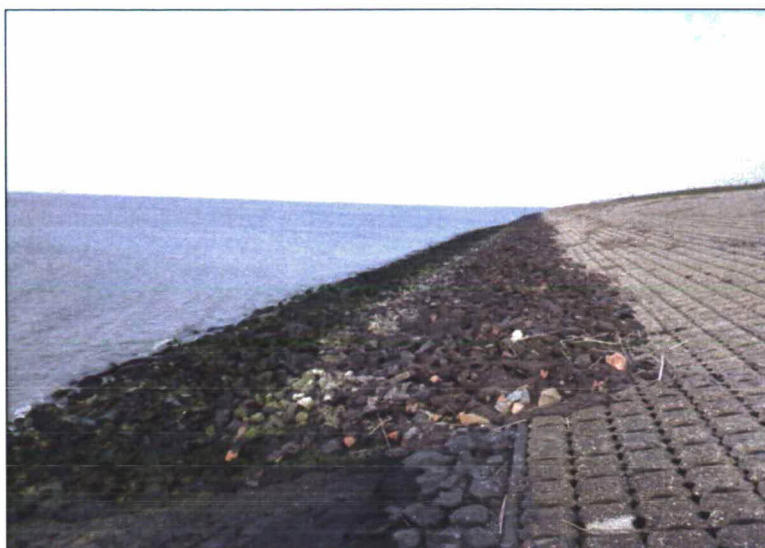
Foto 1 en 2: dp 168 - 169 - Petit graniet is overlaagd met breuksteen 10/60 kg volledig gepenetreerd met gietasfalt en afgestrooid met lavasteen 60/120 mm
