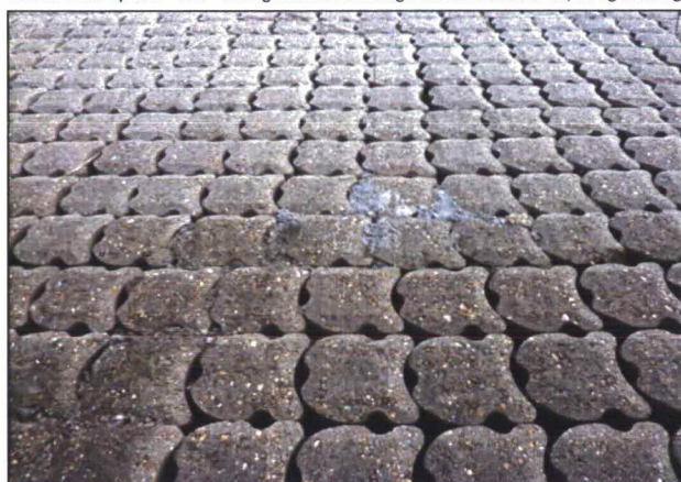
Foto 3 en 4: dp 173 - ruimten tussen betonzuilen opgevuld met beton
