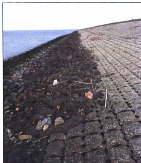
Foto 1 en 2: dp 168 - 169 - Petit graniet is overlaagd met breuksteen 10/60 kg volledig gepenetreerd met gietasfalt en afgestrooid met lavasteen 60/120 mm
