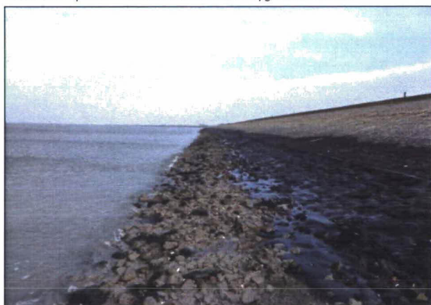
Foto 5 en 6: dp 175-181 - breuksteen overlaagd met breuksteen 10/60 kg volledig gepenetreerd met gietasfalt en afgestrooid met lavasteen 60/120 mm
