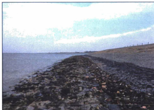
Foto 5 en 6: dp 175-181 - breuksteen overlaagd met breuksteen 10/60 kg volledig gepenetreerd met gietasfalt en afgestrooid met lavasteen 60/120 mm
