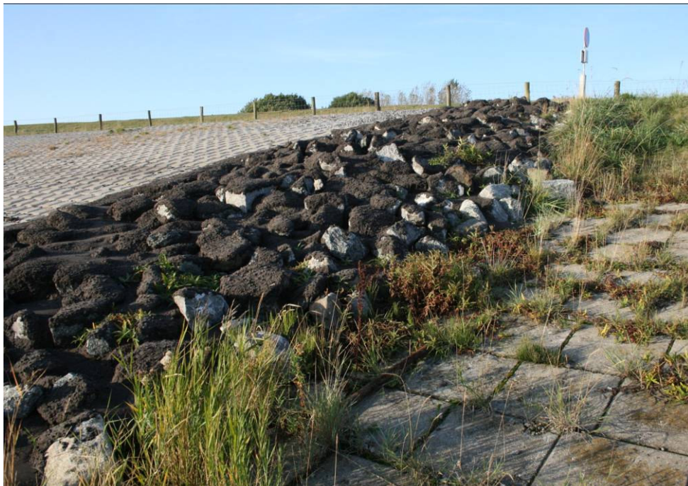
Figuur 2.3 Overgang van reeds voltooide dijktraject Westelijke Sloehavendam (links op de foto) naar het te realiseren Schorerpolderdijk dijktraject.
