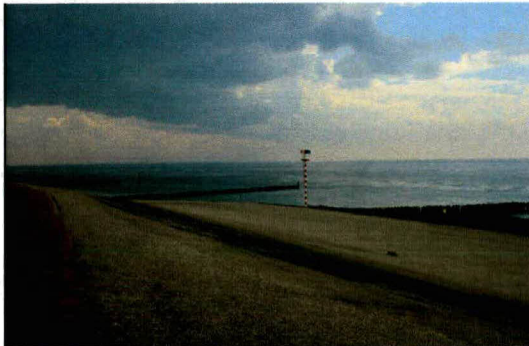
Foto 2.1 De met asfalt beklede dijk
