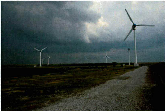
Foto 1.2 Verharde weg onderaan de dijk
