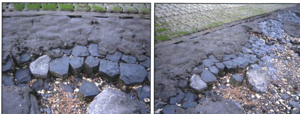
Foto's 1 en 2: herzette basalt op het gedeelte tussen de dijkpalen 308 +50m en 309 +90m
