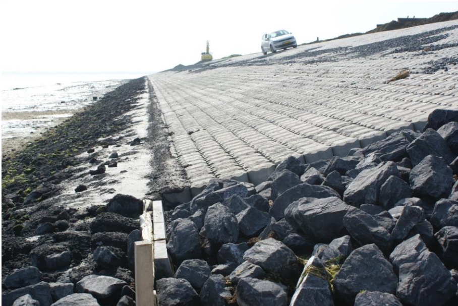
Afb.7. nieuwe dijkbekleding van betonzuilen in 2013.
