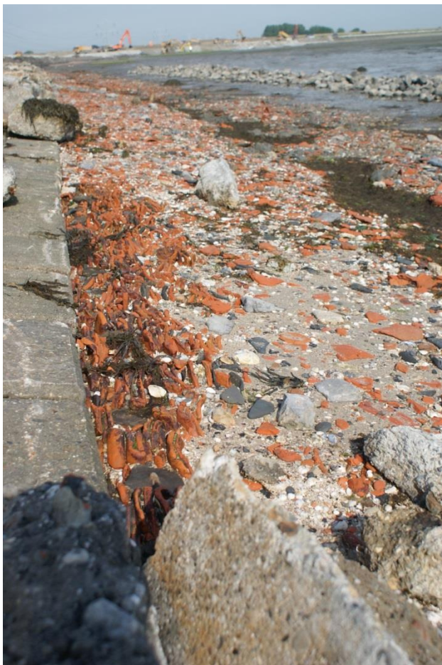
Afb.5. dijkvoet met dakpannen.
