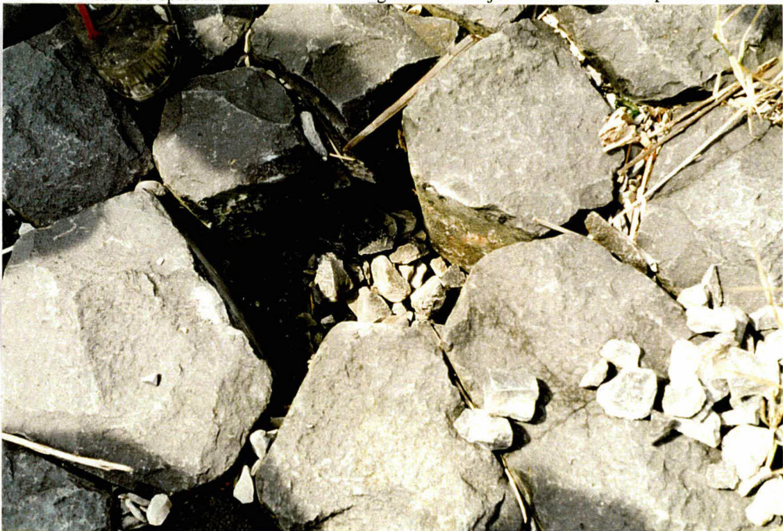
Foto 8 Bij km 74,3 hoog op het talud is een gat gemaakt. De steenslag is hier schoon. De toplaag is niet ingezand maar wel goed gevuld met materiaal.
