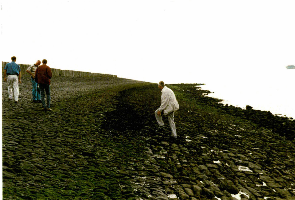
Foto 10 Naast de spuisluis, bij km 75 is aan de onderzijde doornikse steen aanwezig.
