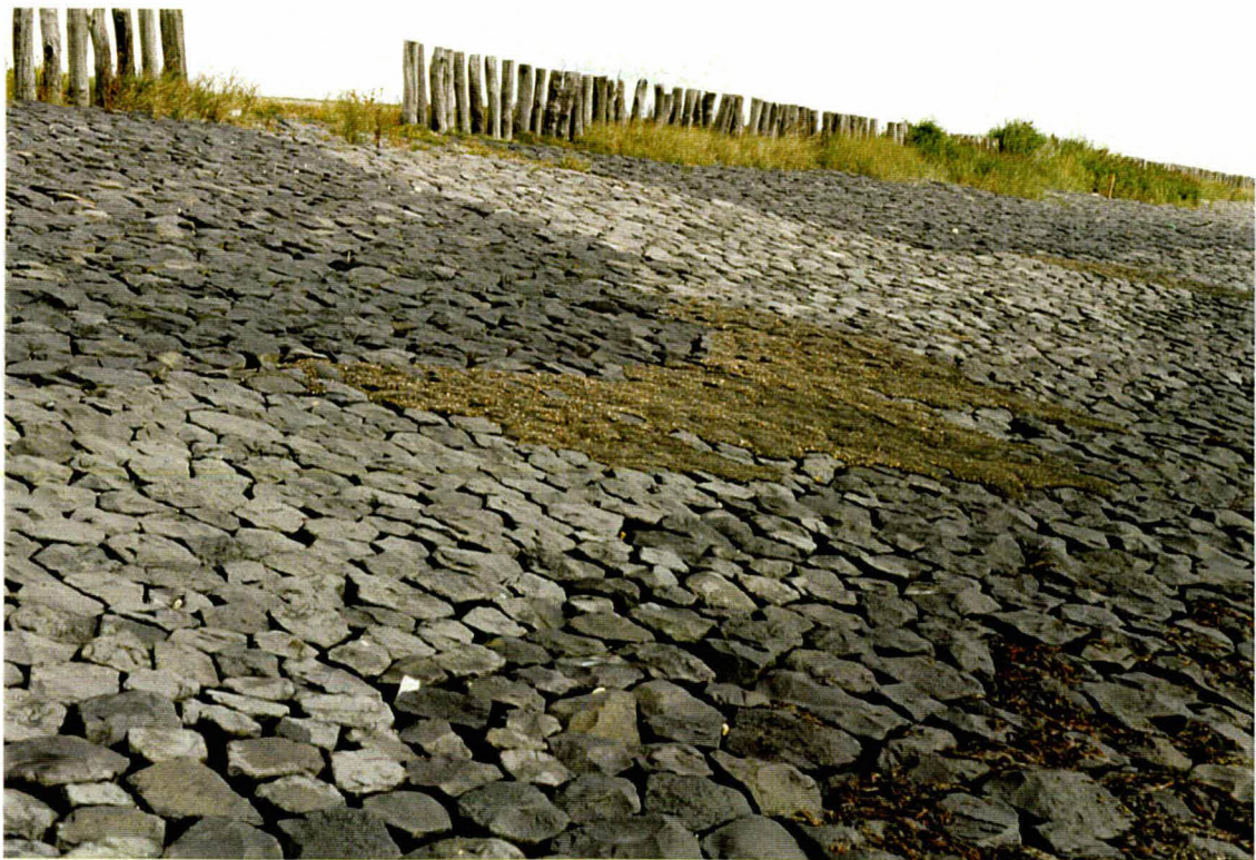
Foto 5 Reparatieplekken bij km 74,3. Let ook op de verschillen in kleur van de basalt.
