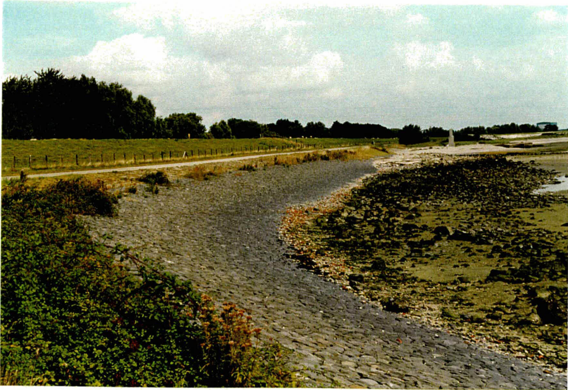
Foto 1 Overzicht van het begin van het vak in oostelijke richting. Aan het einde is het caisson zichtbaar.
