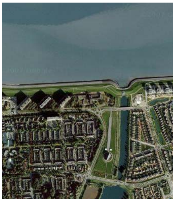
Figuur 1: Luchtfoto Ser-Lippens- en Nieuw-Othenepolder dp 0084 15 – dp 0094 85 (bron: www.maps.google.nl )
