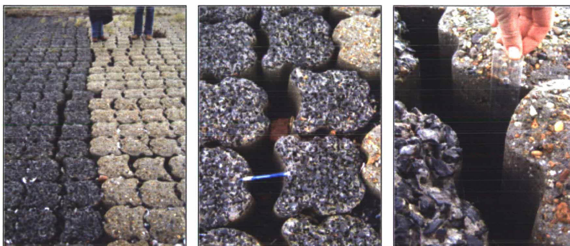
Foto 4, 5 en 6: overgang tussen hydroblokken met en zonder ecotoplaag (dijkpaal 175)
