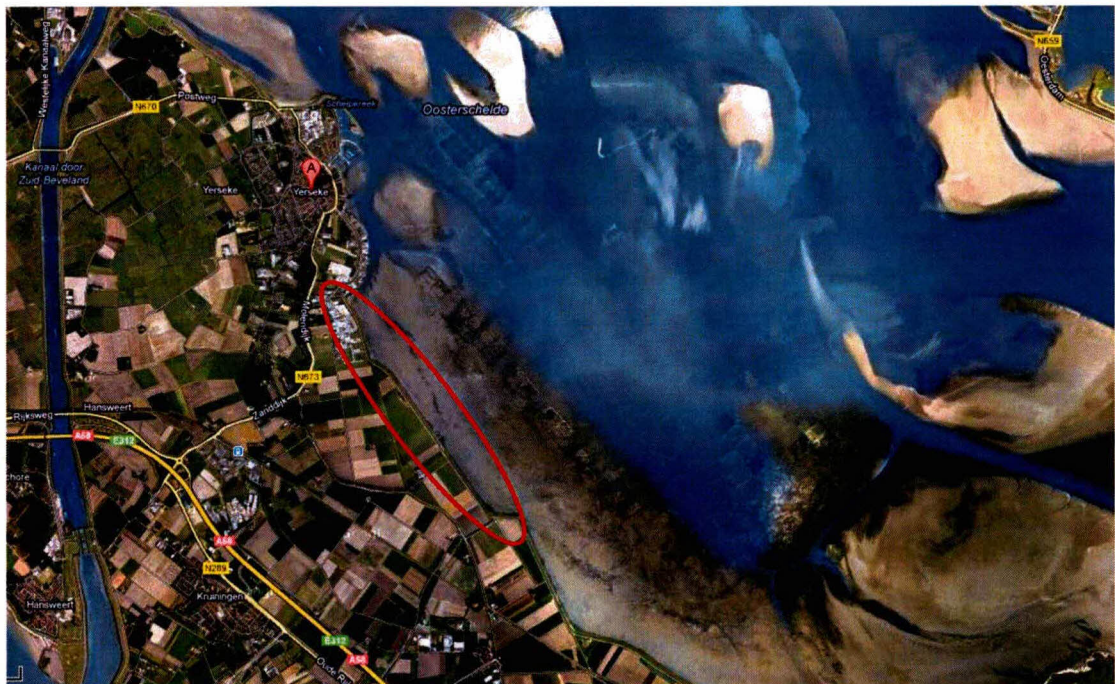
Figuur 1.2: Luchtfoto van het dijktraject St. Pieterspolder, Nieuw Olzendepolder (bron: google.maps.nl).
