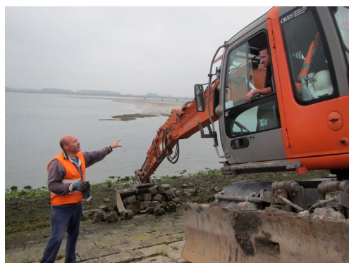
Afbeelding 5. Verwijderen en transporteren van groefwierzuilen.
