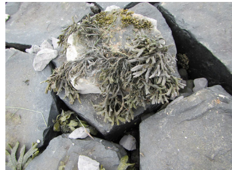
Afbeelding 3. Links Gezaagde kop (basaltzuil met groefwier). Rechts gezaagde kop gelijmd op nieuwe locatie.
