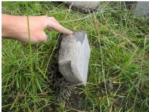
Afbeelding 3. Links Gezaagde kop (basaltzuil met groefwier). Rechts gezaagde kop gelijmd op nieuwe locatie.
