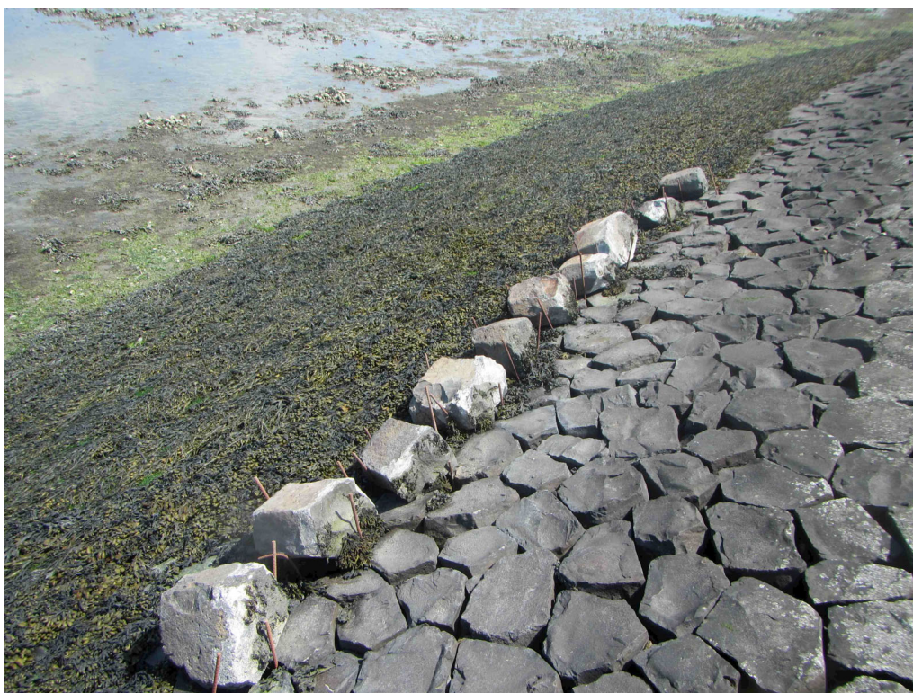
Afbeelding 4. Neerleggen van zuilen met groefwier (Zandkreekdam).
