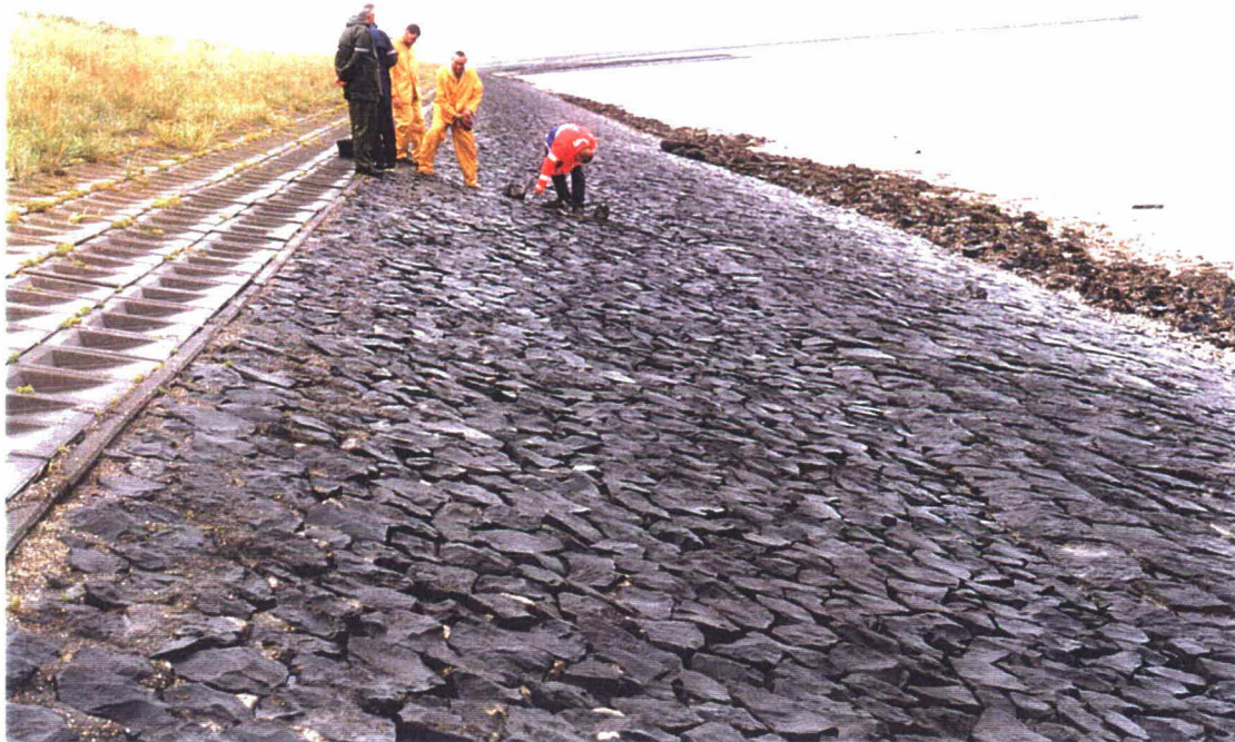
Foto 13 Overzicht van vak 29702. In dit vak is niet erg ruim gepenetreerd. Het oppervlak oogt wat rommelig.
