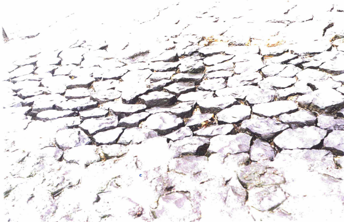
Foto 10 In de bocht bij km 30,1 is de bekleding minder goed. Hier is een gedeelte te zien waar minder asfalt zit en waar de zuilen wat voorover zijn gezakt.
