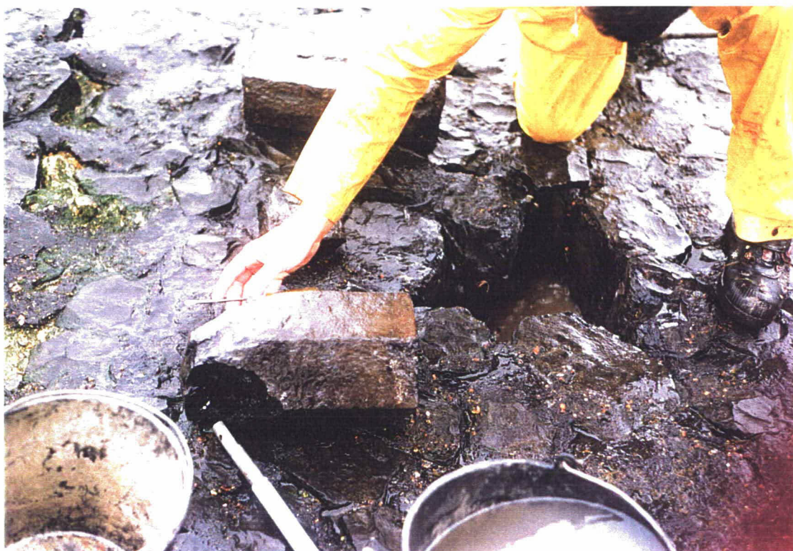
Foto 8 Gat bij km 30,4. Er staat nog water in het gat.
