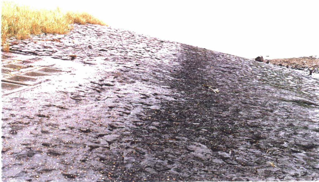
Foto 11 In de bocht bij km 30,1 is het gepenetreerde gedeelte hoger opgetrokken dan in de rest van het vak.
