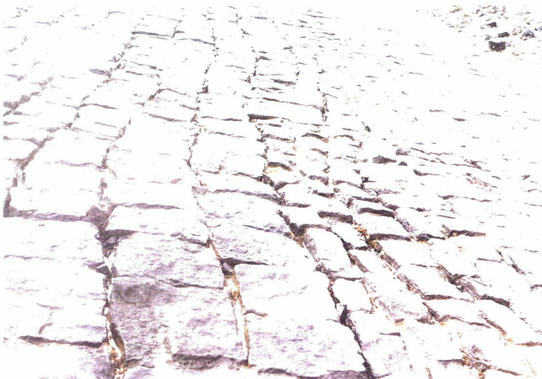
Foto 16 Bekleding 29801: met beton gepenetreerde granietblokken. Er is een afwisseling van grote en kleine blokken. Wellicht is een deel van de blokken staand geplaatst.
