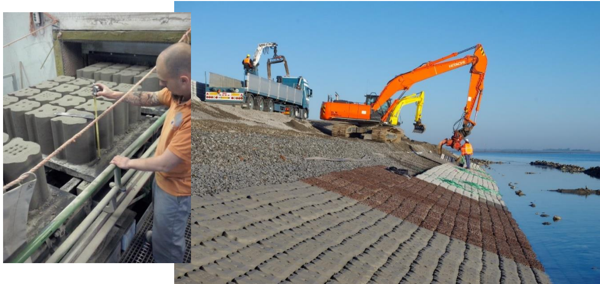
Figuur 3. Productie en installatie van de BfN-blokken.
