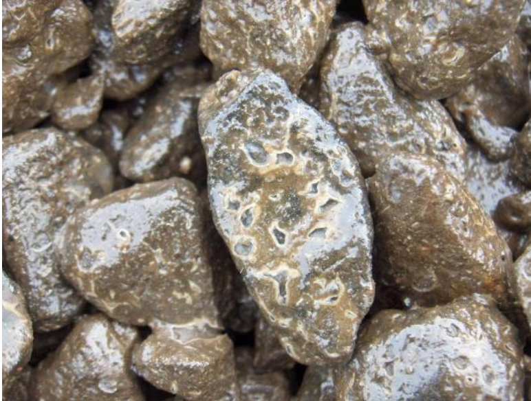
Afbeelding 3. Regen kort na aanbrengen van de PBA-bekleding kan het oppervlak aantasten, maar resulteert niet in een verzwakking van de structuur.
