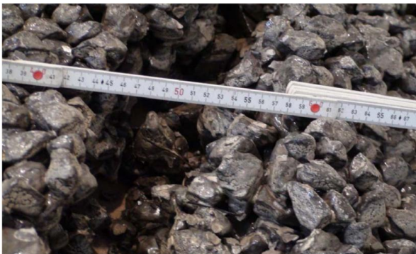
Figuur 3. Opname van een scheur in polyurethaan gebonden bekleding (foto: Oumeraci et. al., 2010).
