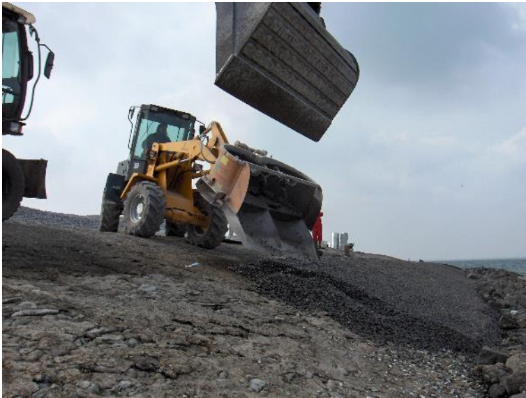
Figuur 1. Aanleg van een taludbekleding met polyurethaan gebonden breuksteen (foto: Bijlsma, 2007)
