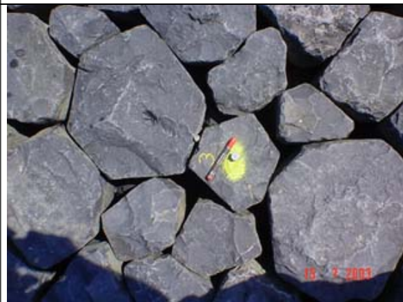
Zuil 1-3 voor inwassen
