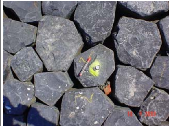
Zuil 1-2 voor inwassen
