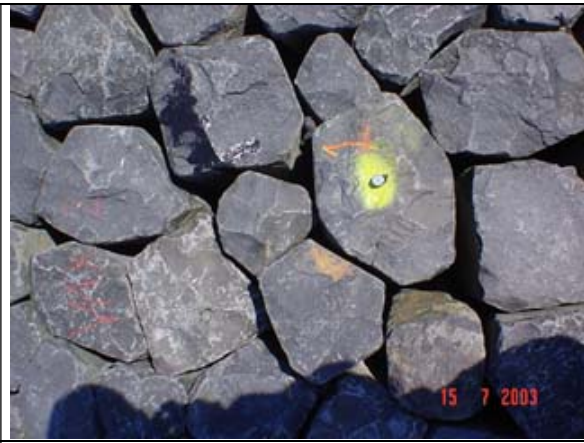
Zuil 2-1 voor inwassen
