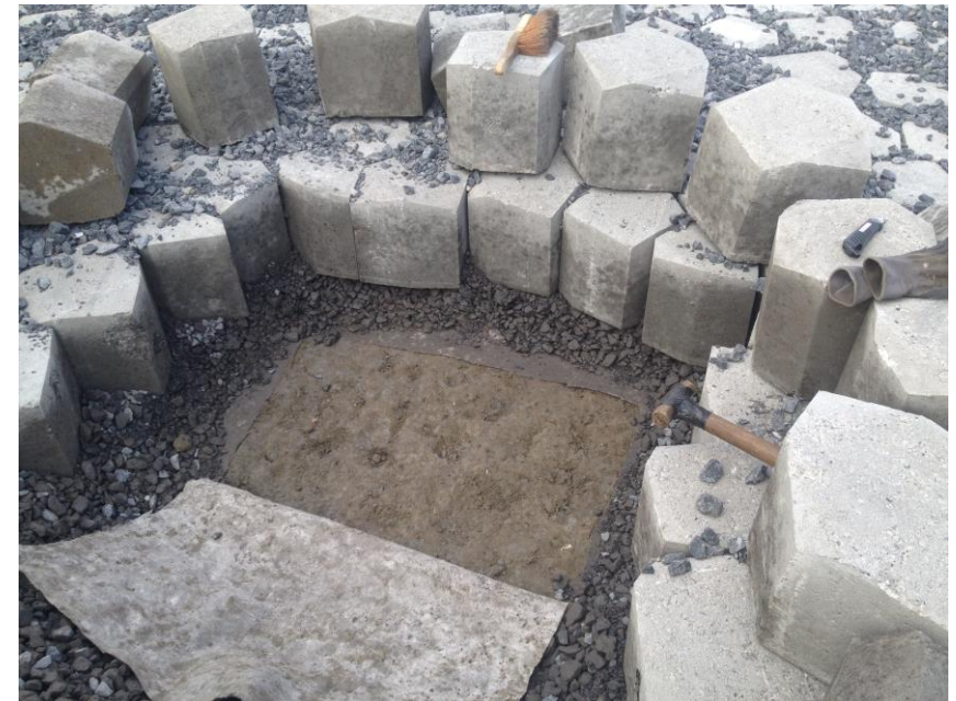
Foto 2 : De zetsteen constructie, de straatlaag, met daaronder geotextiel en de stabilisatie laag van Geocrete®.
