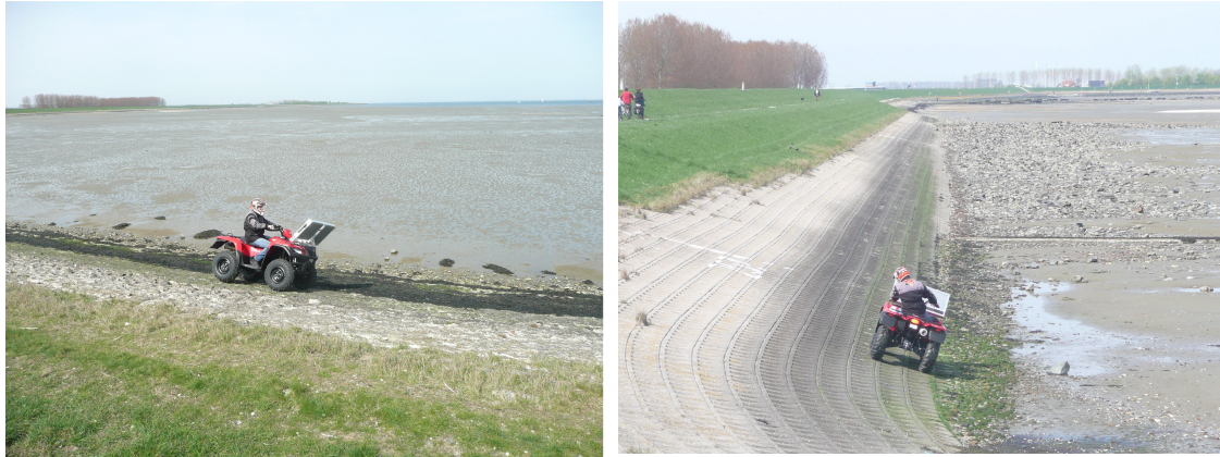
Figuur 1: Een duo microgolven scanner systeem is gemonteerd op een utility quad waardoor je op een snelle manier een dijk kunt inmeten, zoals hier te zien is tijdens de meting op maandag 11 April 2011 bij Kattendijke, Zeeland.
