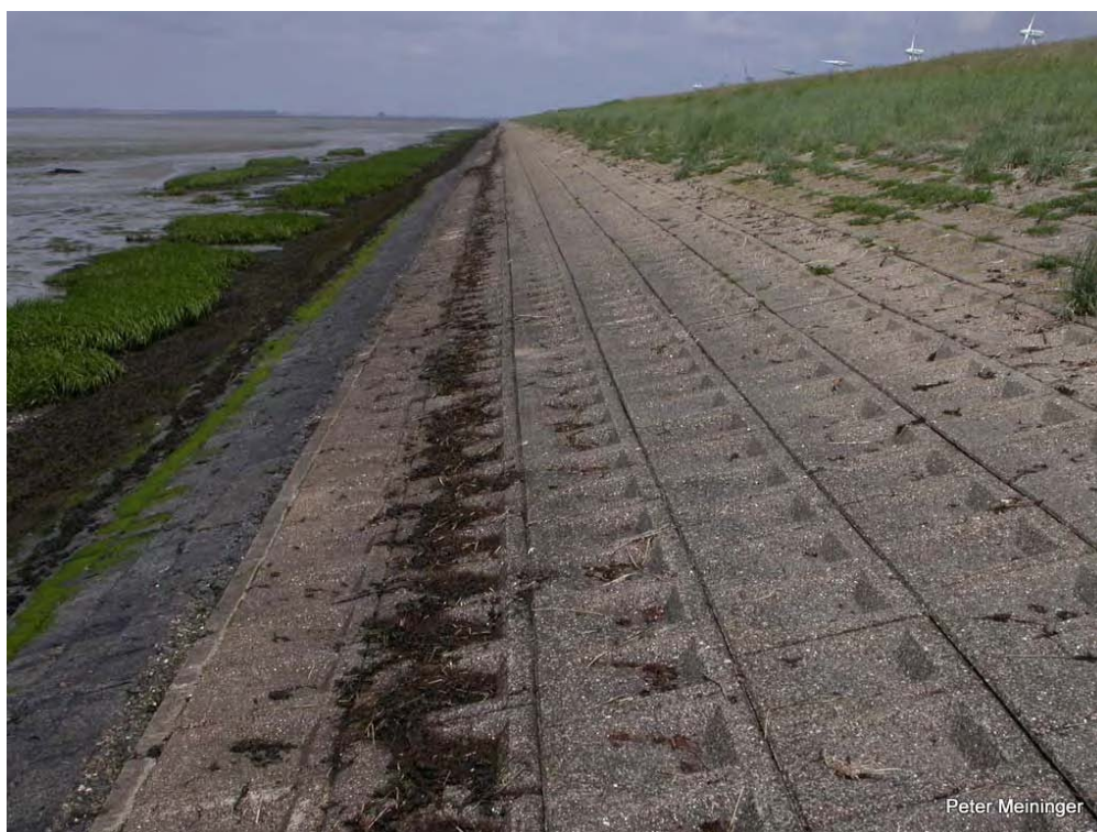
Foto 1. Oesterdam met zone koperslabblokken, zone Haringmanblokken kaal en begroeid met zoutplanten.
