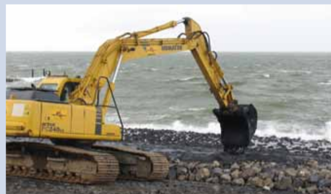
Gieten van asphalt over breuksteen
