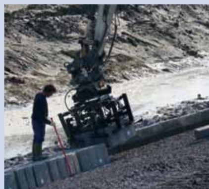
Aanbrengen van nieuwe betonzuilen
