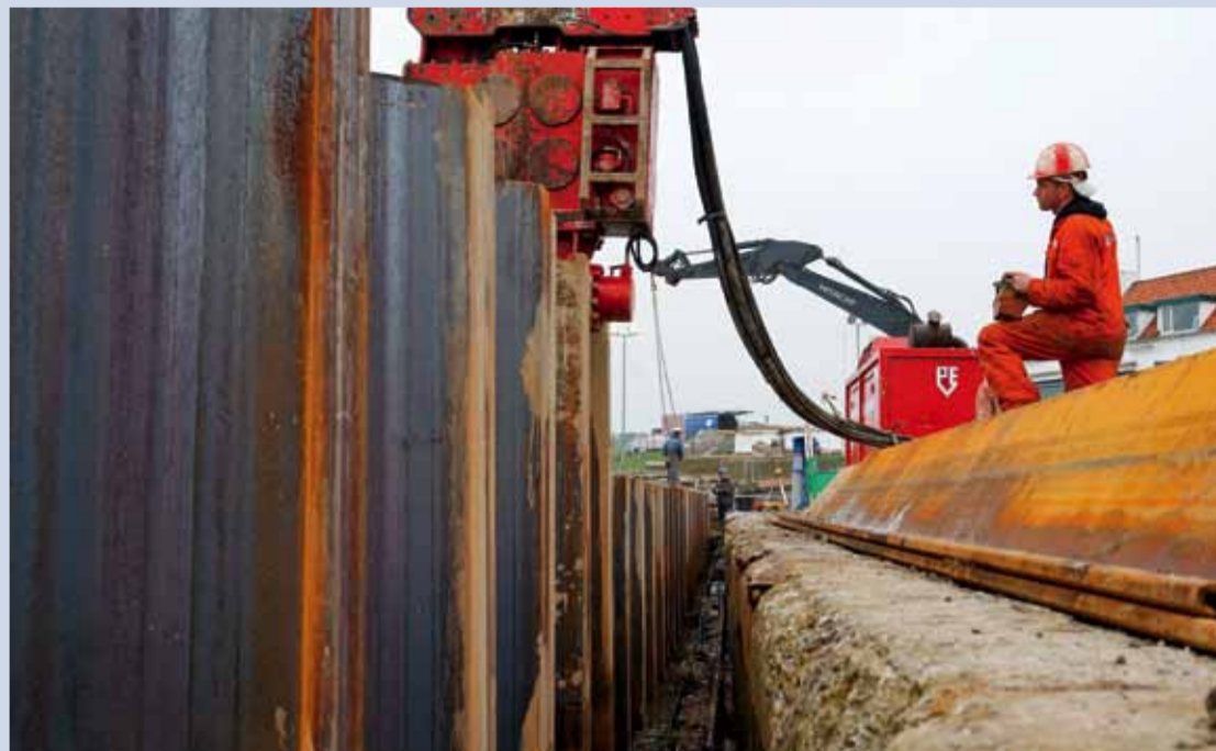
Damwand plaatsen in de Flauwershaven
