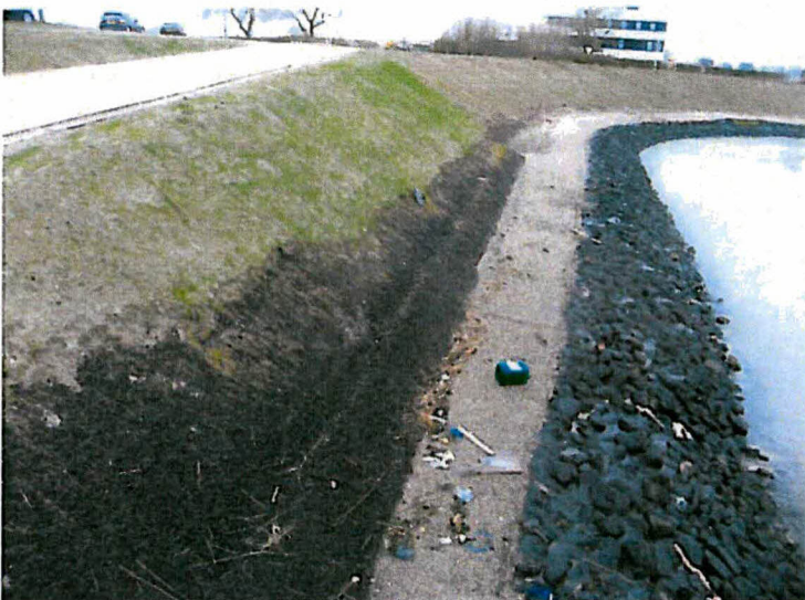
Uitgespoelde afdeklaag
