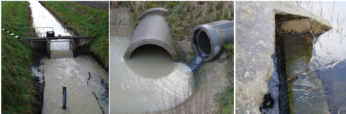
Afbeelding 3.4 Links: klepstuw aan de Zuiddijk bij Dreischor; midden: duiker ter hoogte van de Nieuweweg; rechts: drempel tussen het noordelijke en zuidelijke deel van het Dijkwater
