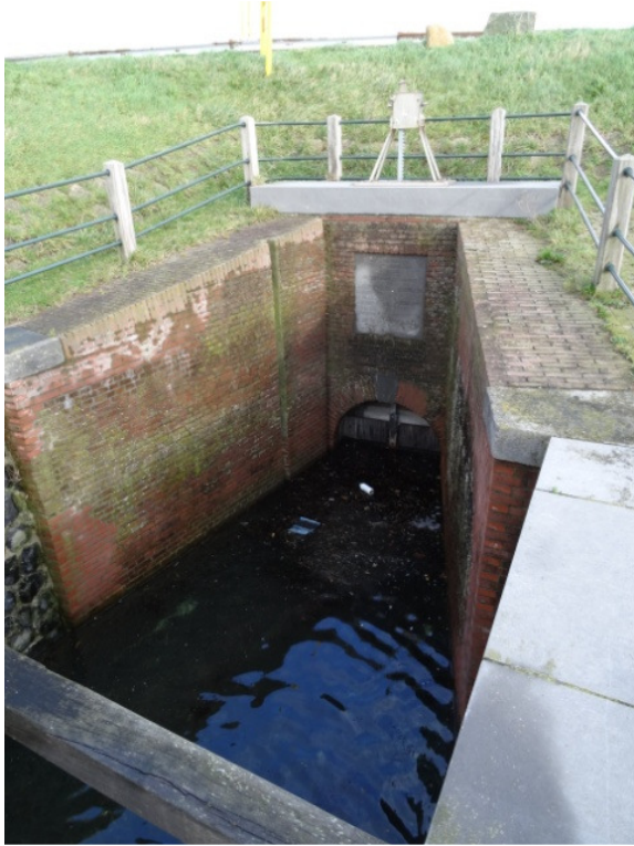
Afbeelding 3.7 Aanzicht van het sluisje vanaf de zijde van het Grevelingenmeer
