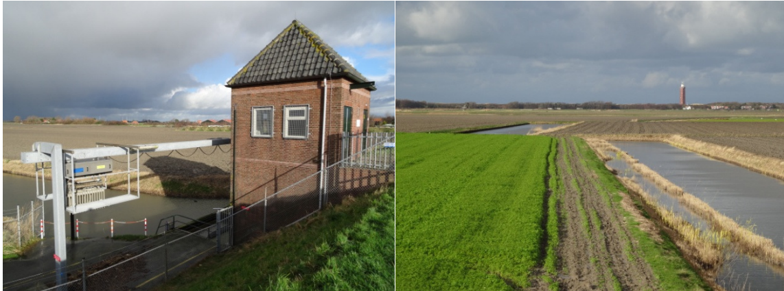
Afbeelding 3.6 Gemaal Kilhaven (links) en een impressie van het achterliggende poldergebied (rechts)
