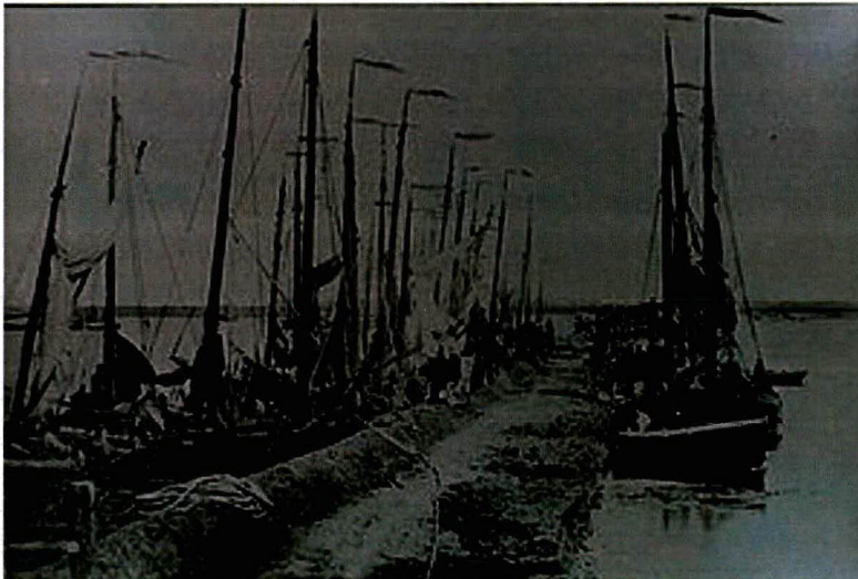
Afb. 17. Vlet scheepjes bij aanleg dijk 19e eeuw
