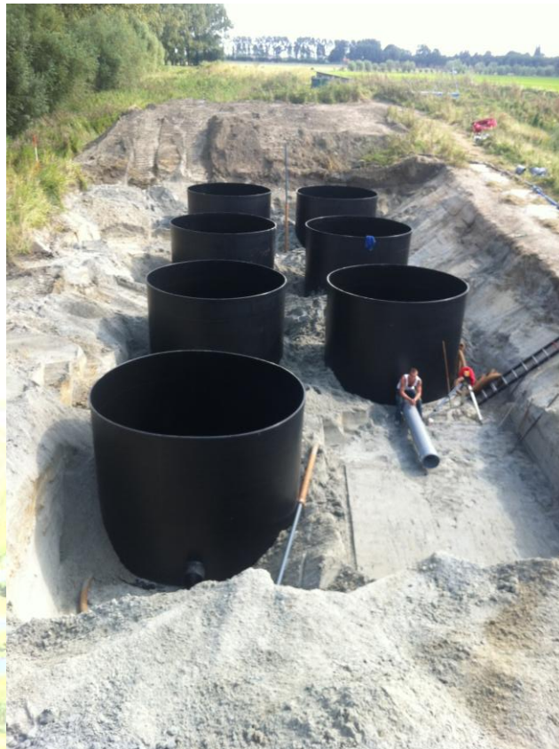
Afbeelding 3 plaatsing van de mosselbakken met buizen voor doorstroom
