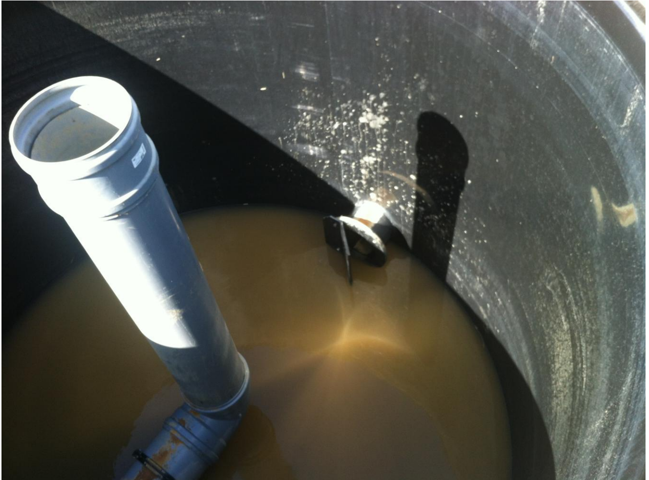
Afbeelding 4 instroompunt water met richt plaat en uitstroom met afvoer over de bodem.
