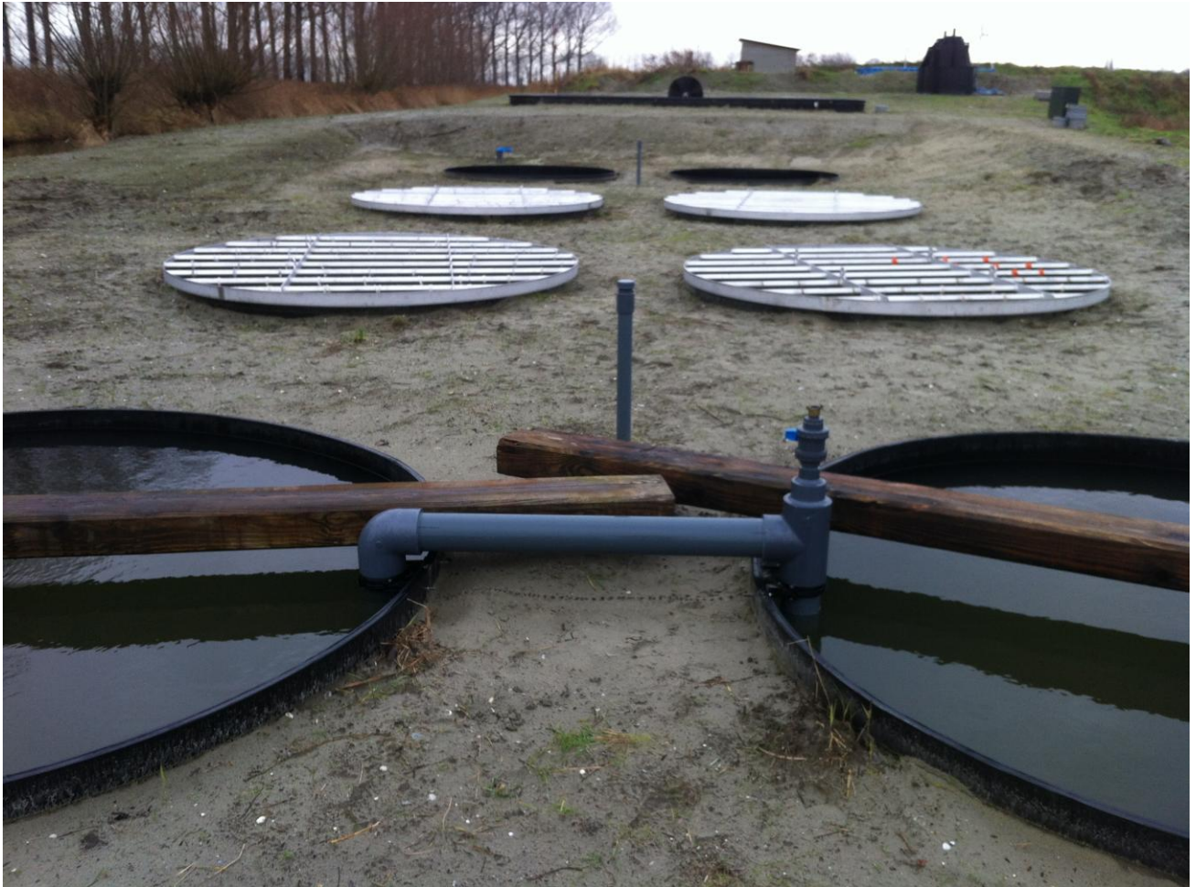
Afbeelding 5: de 8 mosselbakken, met op de voorgrond de hevel voor noodvoorziening (als 1 pomp uitvalt) daar achter de race way en daar weer achter de ontijzeringstorens
