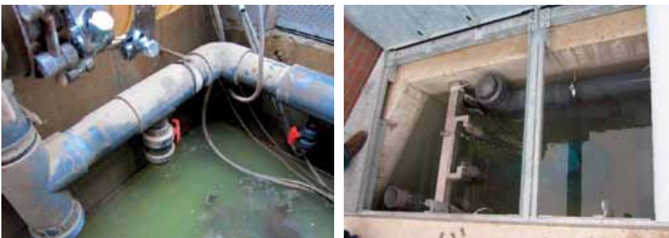
Figuur 3.5 Reservoir bedriegertje gevuld met grondwater (links) en drinkwater (rechts) foto's Arthur Nijhof
