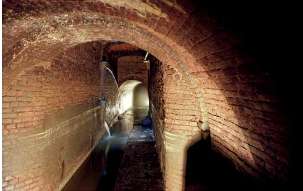
Figuur 1.2 Oude Vest: een overkluisde riolering in Breda
