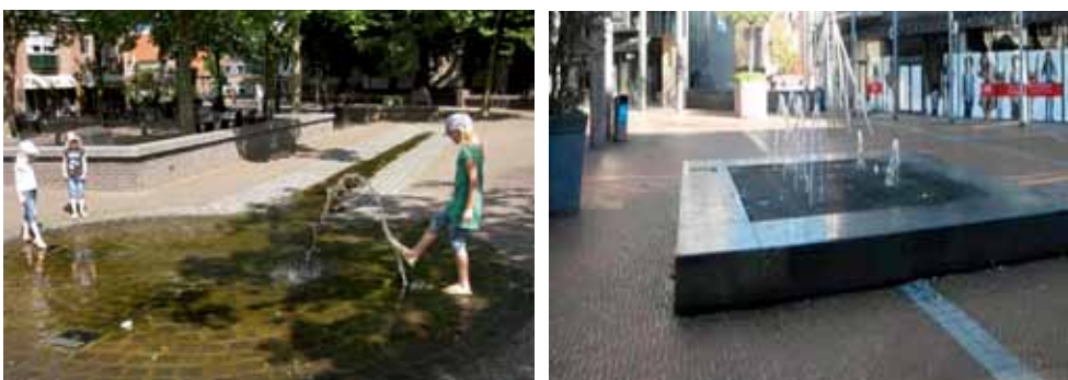
Figuur 3.6 Bedriegertjes waar verontreinigende stromen wel (links) en niet (rechts) kunnen afstromen in het reservoir
