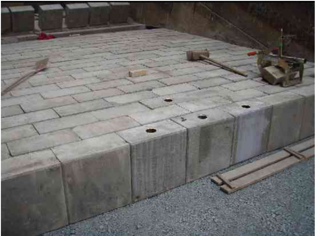
b) Inbouw bloklaag
