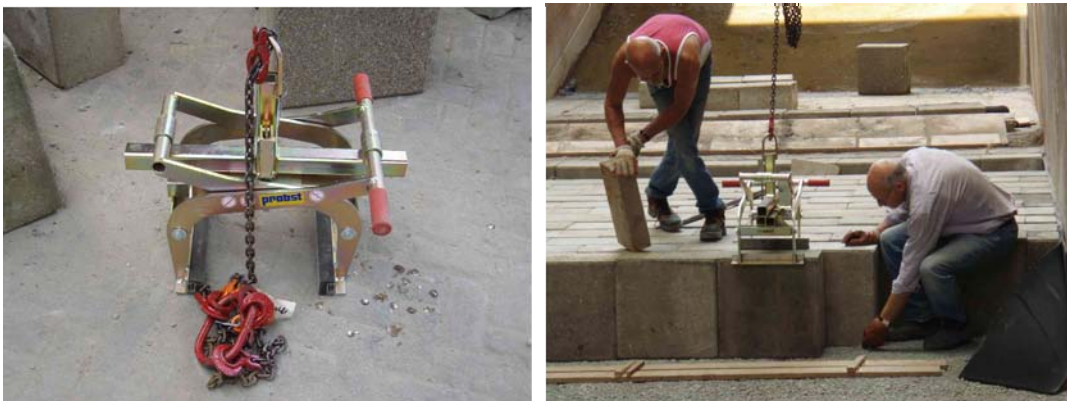
Figuur 3 Plaatsen van blokken
