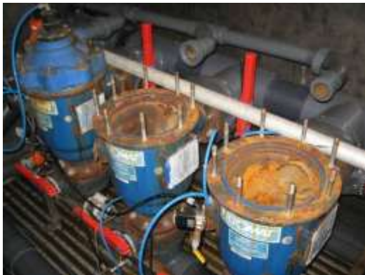
De oorspronkelijke 50 µm filters aangetast
