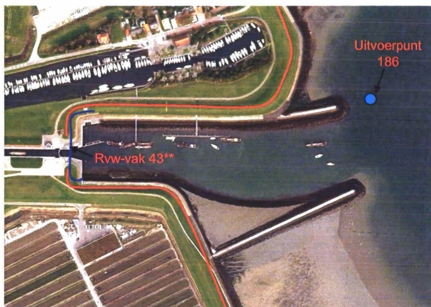
Figuur 7: Overzicht sluisencomplex, met daarbij in het rood aangegeven de ligging van de huidige primaire waterkering en met blauw randvoorwaardenvak 43**
