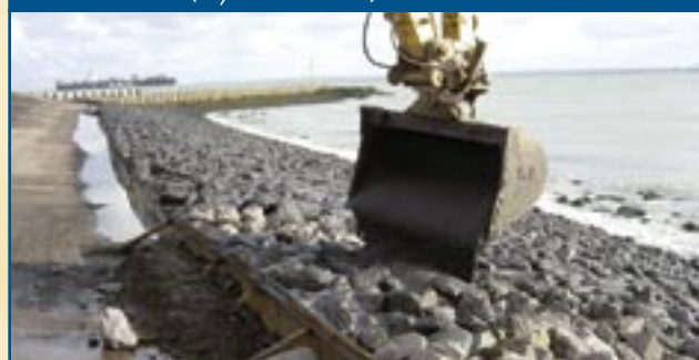
Breuksteen, ingegoten met gietasfalt
