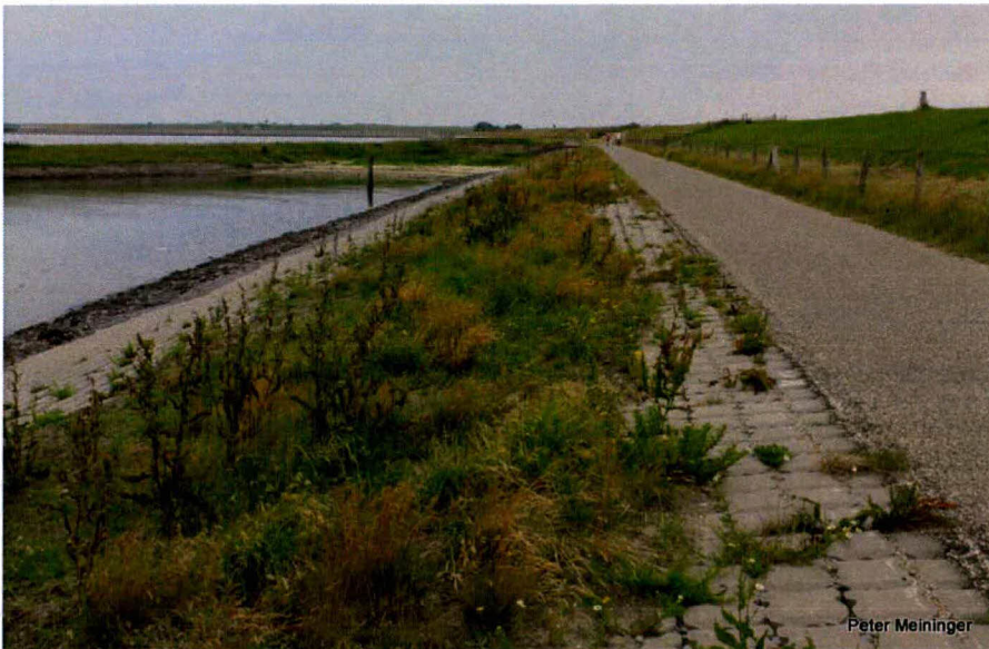
Zeedijk Burgh- en Westlandpolder, Schouwen-Duiveland, in de luwte van de Westbout. Uitgevoerd in 2008 en afgestrooid met kleirijke grond. Foto: juli 2012.
