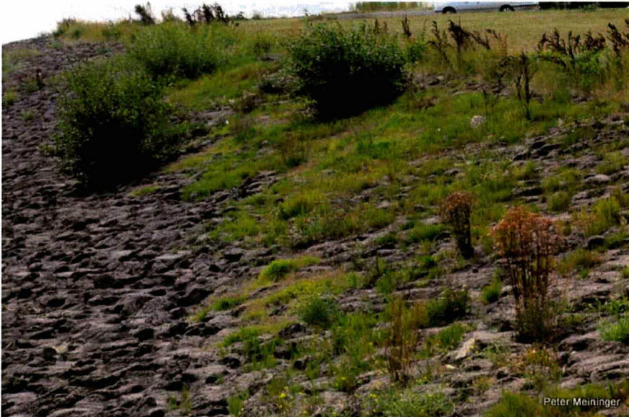
Zeedijk Grevelingendam. Uitgevoerd in 2009. Zelfs breuksteen met gietasfalt is hier al opmerkelijk gevarieerd begroeid. Luw gelegen met een voorland van slik. Foto: juli 2012.
