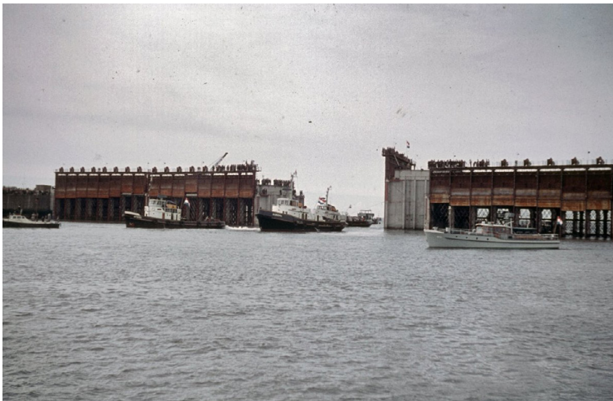
Sluiting Veerse Gat middels doorlaat caissons - beeldbank RWS
