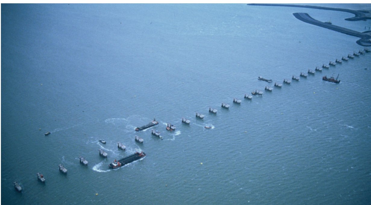
Bouw pijlers Oosterscheldekering - beeldbank RWS
