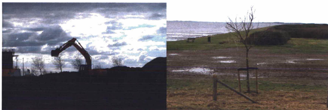
Foto 1: Werkzaamheden op de locatie ter hoogte van de verborgen glooiing waar bomen zijn gekapt.
