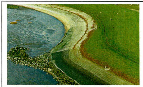
Nieuwe boventafel sluit aan op oude ondertafel
