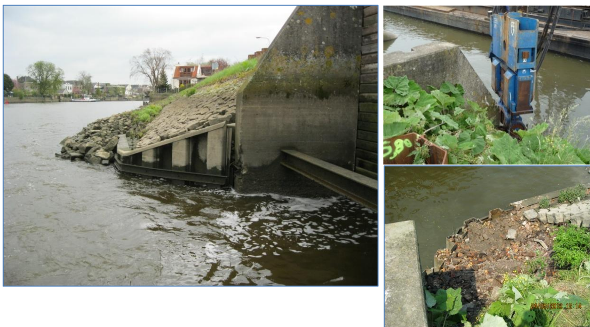
Figuur 6.5 Foto's situatie getrokken damwandplanken te Gouderak, gemaal Verdoold
