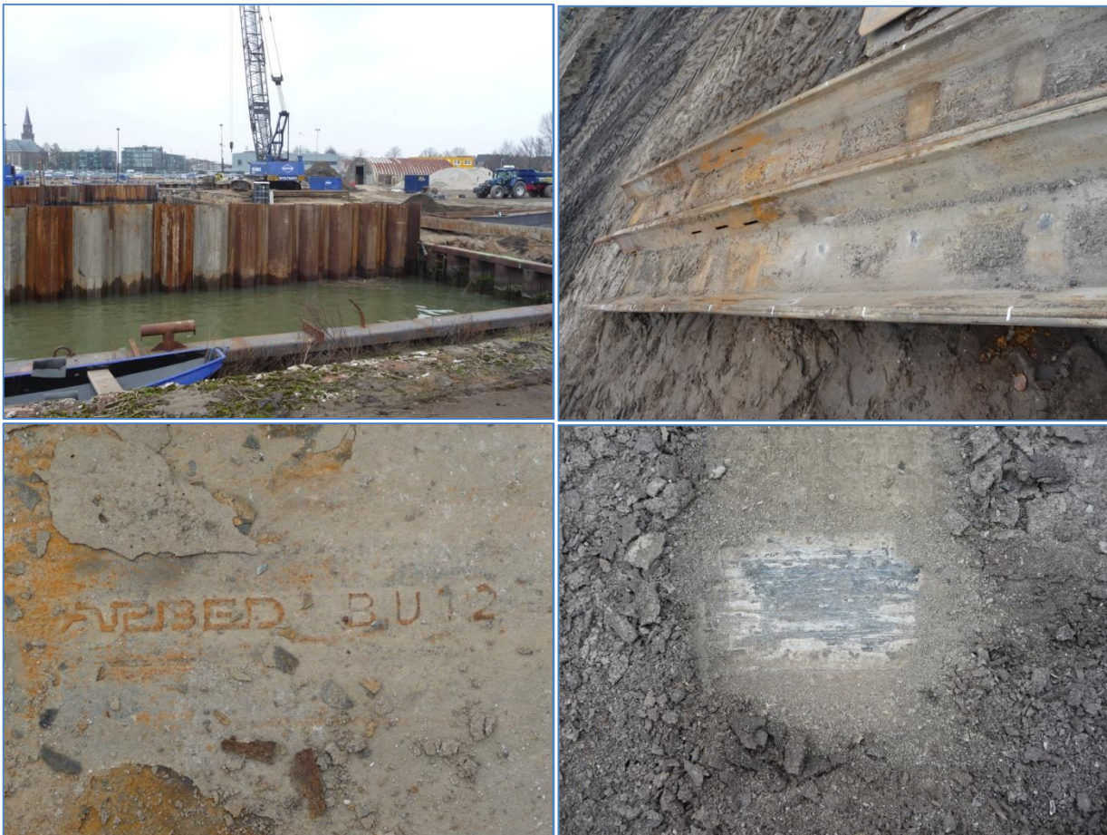
Figuur 6.15 Foto's damwandplanken Alblusserdam
