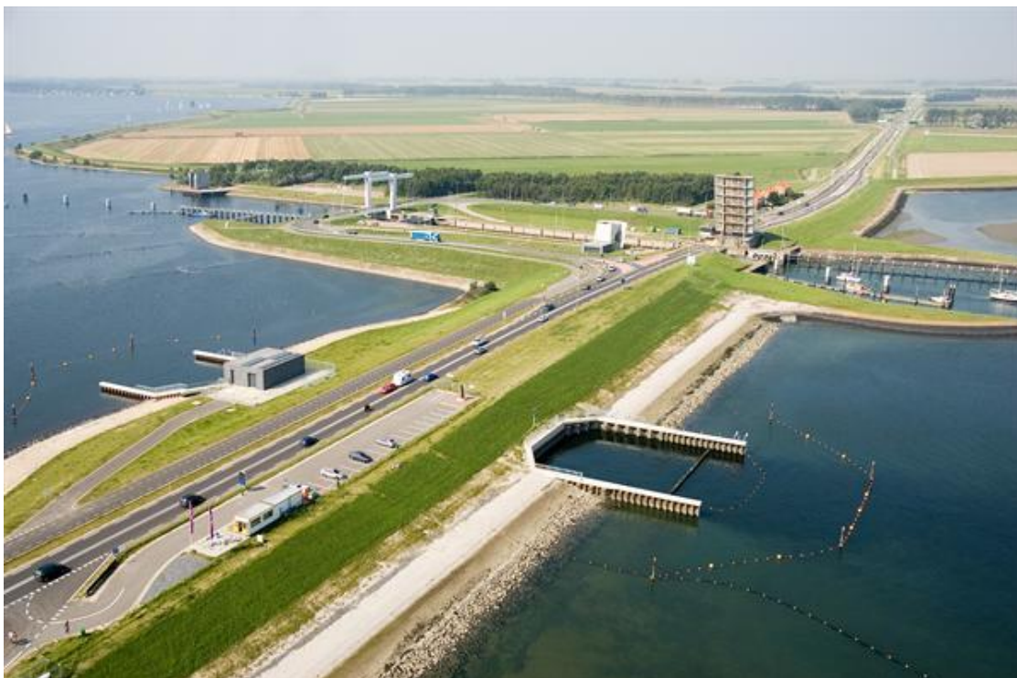
Figuur 2.3 Zandkreekdam met doorlaatmiddel Katse Heule (bron: beeldbank.rws.nl)
