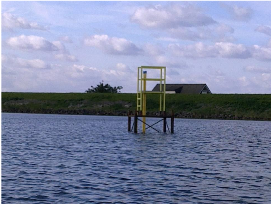
Foto 2.1 Werkplatform met peilbuizen in het Markermeer
